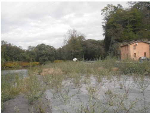
Photo d'un site bâché et bouturé de saules sur les Usses
