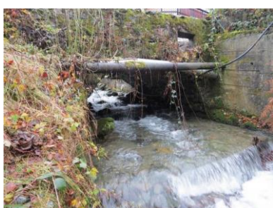
Reprise du parement intérieur de l'ouvrage OAP4
