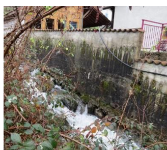
Pied de mur en amont du pont (bâti)
