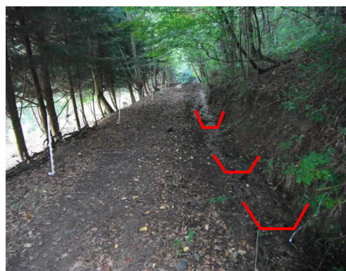
Création d'un fossé
