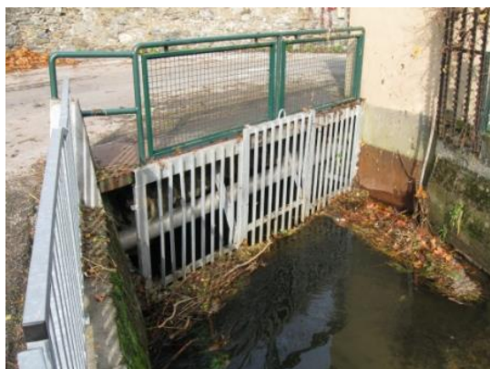
Grilles à l'entrée du parc du Château
