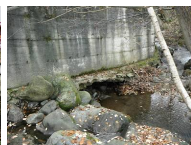
Pied de mur à l'aval du pont (jardins)
