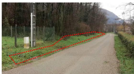
Remarque : si le fossé n'est pas possible en raison de la présence des réseaux, on pourra mettre en place une digue de hauteur 1m, mais l'emprise sera plus importante et le cout également (environ 50 000 € HT supplémentaire, hors foncier).
