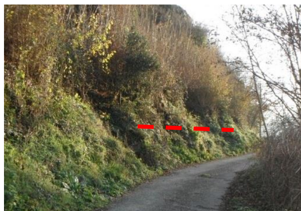
Traversée sous le chemin des Guetteaux
