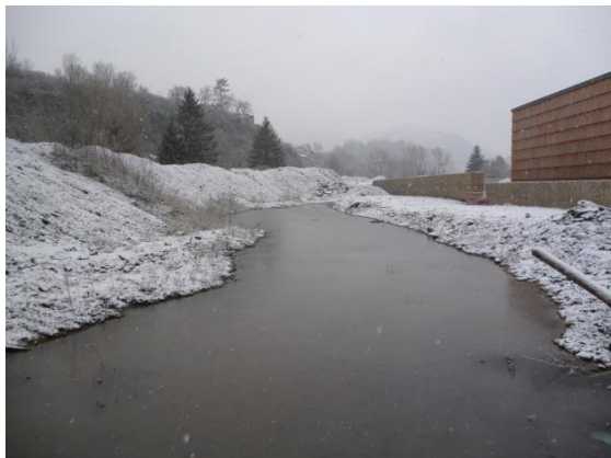
Nappe haute visible dans un déblai
