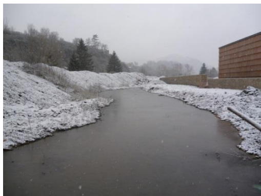
Photo 4 : Nappe haute visible dans un déblai
