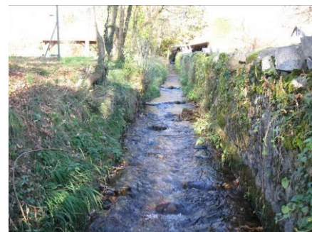
Photo 33 : Tracé recalibré dans un secteur urbanisé
