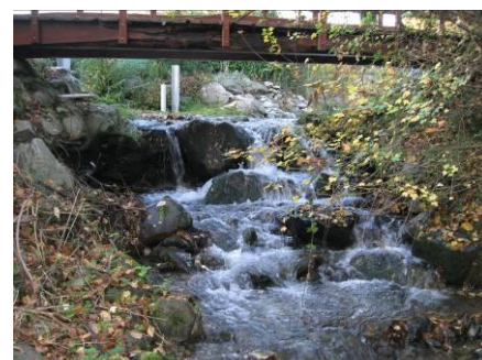
Photo 40 : Seuil sélectif pour la truite
