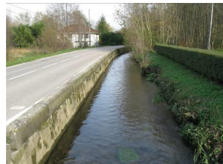
Photo 21 : Aspect du Vernon à Vizille
