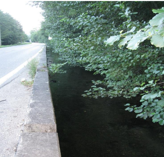
Le Vernon secteur extrémité sud
