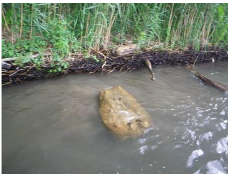
Illustration 96 : Présence de bois flottant et érosion de la rive
