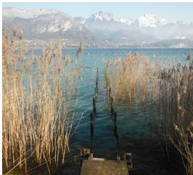
Automne 2013 : après suppression du ponton, constat d'une progression de la roselière.
