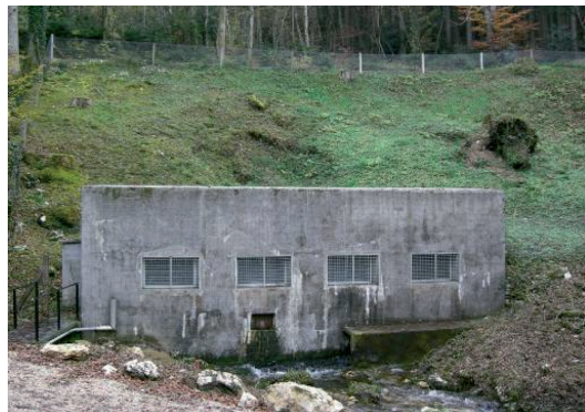
FIGURE 2.12 – Captage de la source de La Combe
