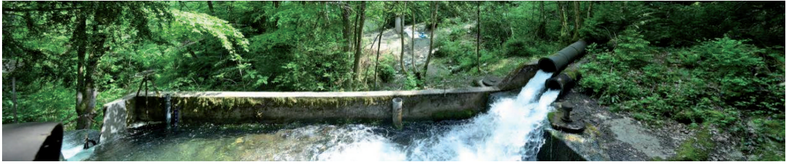
FIGURE 2.9 – Evacuation du trop plein des sources hautes de La Roche Saint Alban
