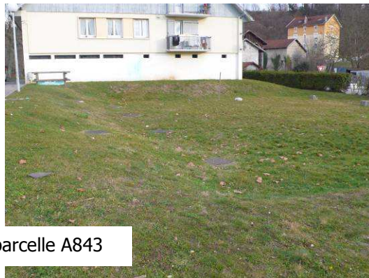
lieu probable du rejet parcelle A843
