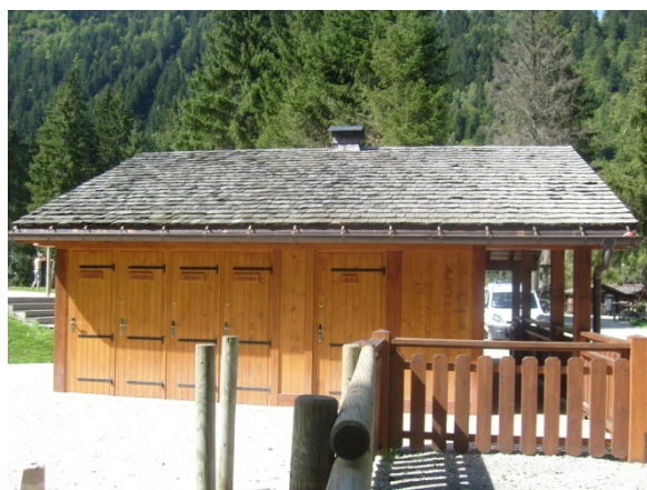
Figure 16: Sanitaires à l'entrée du lac de baignade du Pontet (Source: photos CIDEE)
