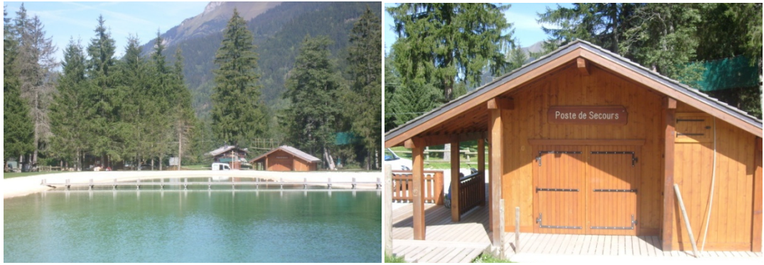
Figure 13 : Vue du poste de secours depuis le pont séparant les 2 bassins (à gauche) et vue détaillée du poste de secours (Source: photos CIDEE)
