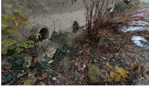
Buse Ø500 mm en rive gauche
