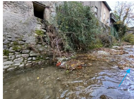
Enrochement en rive gauche
