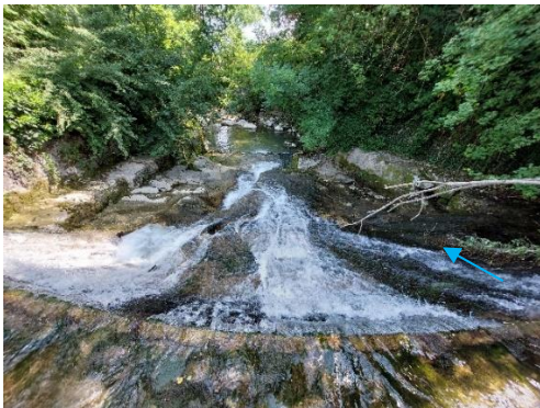
Seuil du canal usinier (PM2200) (HYDRETTUES, 2023)
