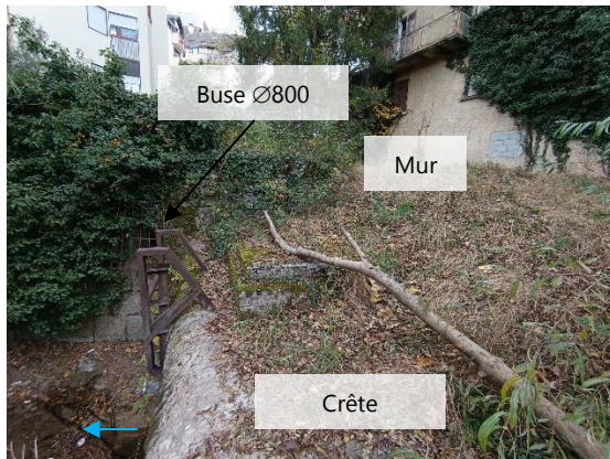
Haut de seuil bétonné et mur en aval (PM0)
