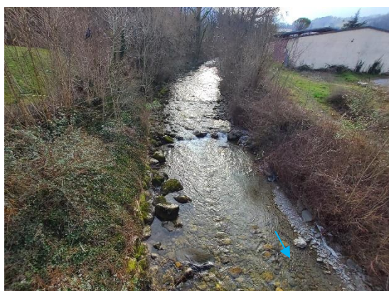
Vue amont du pont de la rue de la Forêt (PM560)
