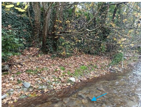
Enrochement libre avec mur en arrière-plan en rive droite
