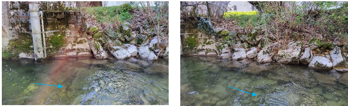
Figure 27 : Photographies de la stabilité du pont vieux
