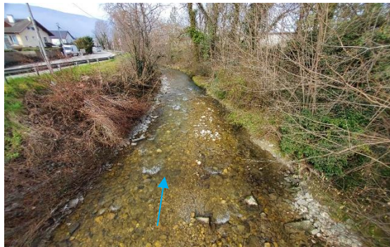
L'Hyères vue de la passerelle piétonne (PM385 aval)
