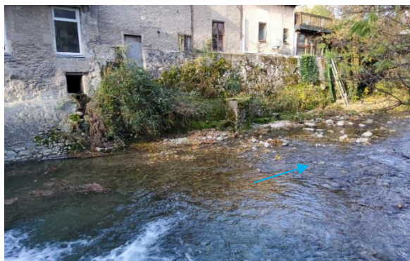
Bâtiments en rive gauche (PM04 aval)
