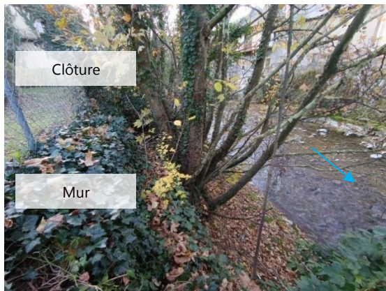
Mur et clôture en rive droite (PM16 aval)
