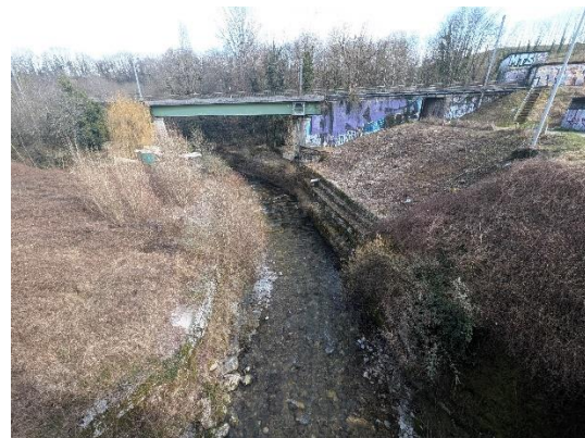
Figure 11 : Pont ferroviaire vu du pont de la route de Lyon
