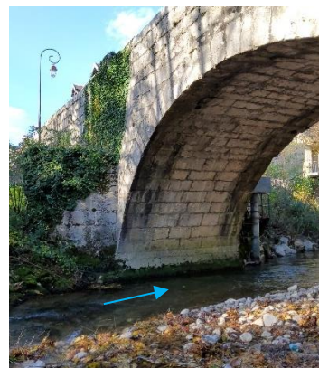
Sous l'arche du pont vieux (PM47 amont)
