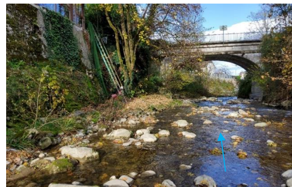
Mur en pierre liaisonné (PM28 aval)
