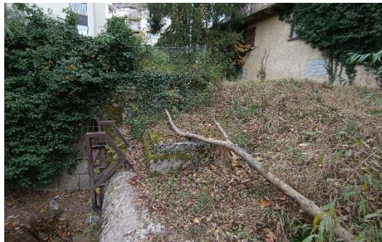
Bloc sur la crête du seuil en rive droite, mur et buse Ø800 mm
