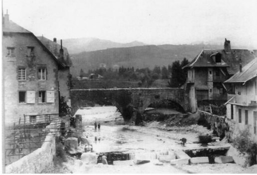
1926 : remplacement de l'ouvrage en bois par un ouvrage en maçonnerie
