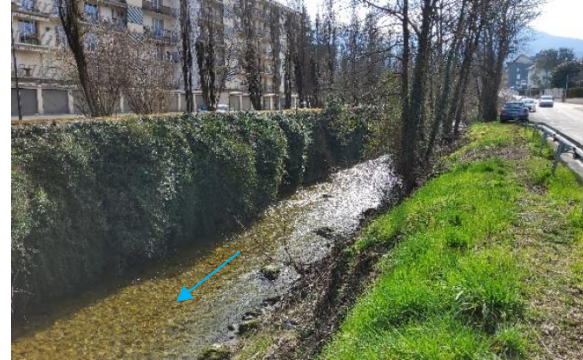
L'Hyères rectiligne et contrainte (PM205 aval)
