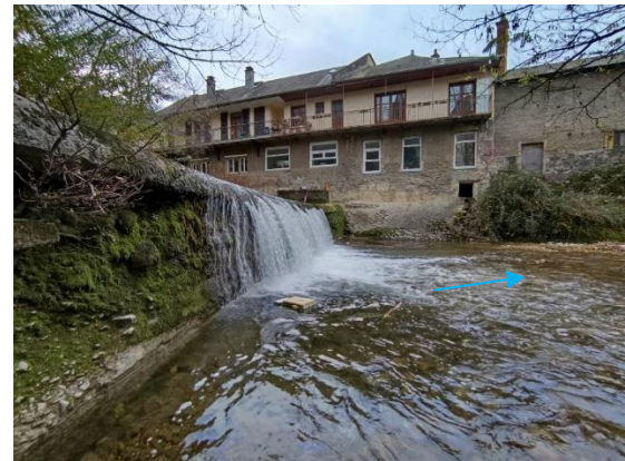
Chute du seuil et mur en pierre liaisonné (PM0)
