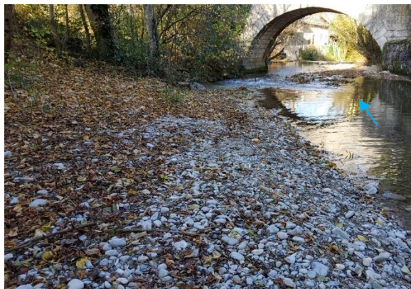
Atterrissement en amont du pont vieux (PM74 amont)
