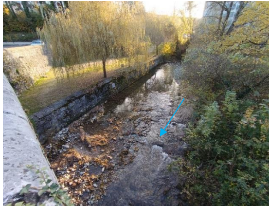
Mur rectiligne (PM33 amont)
