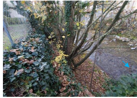
Mur en rive droite
