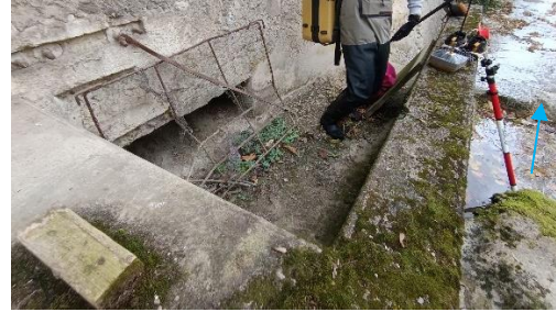
Mur de protection du canal en rive gauche
