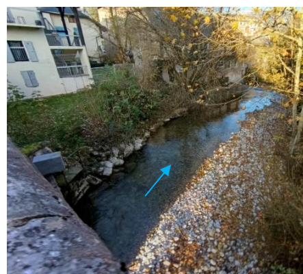
Consolidation de berge en aval du pont vieux (PM33 amont)
