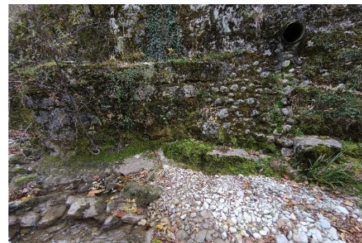
Epis en rive gauche et buse Ø300 mm
