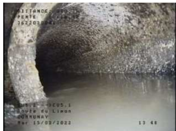
Niveau d'eau conséquent – P135 du rapport ITV
