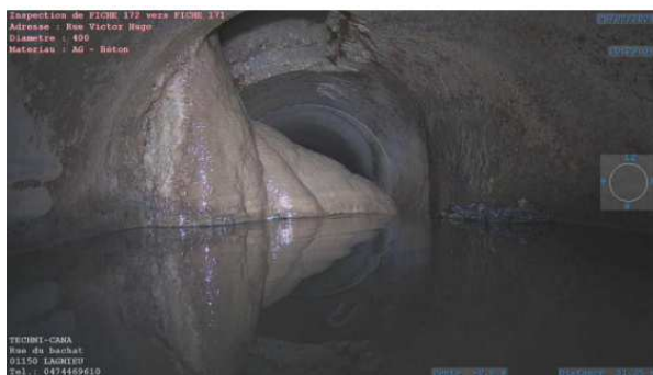
Amont de la concrétion – P75 du rapport ITV
