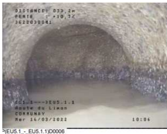
Niveau d'eau conséquent – P135 du rapport ITV
