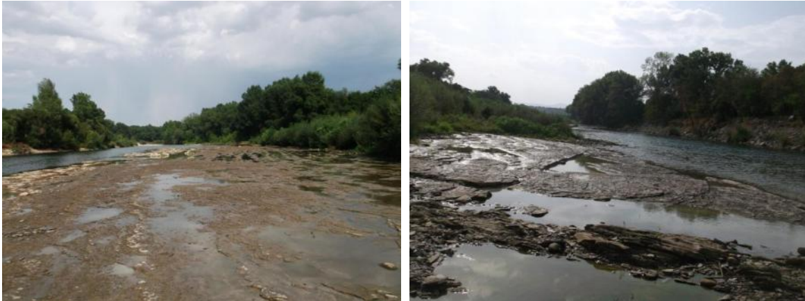
Incision en aval du pont de Grospierres : lit calé sur le substratum
