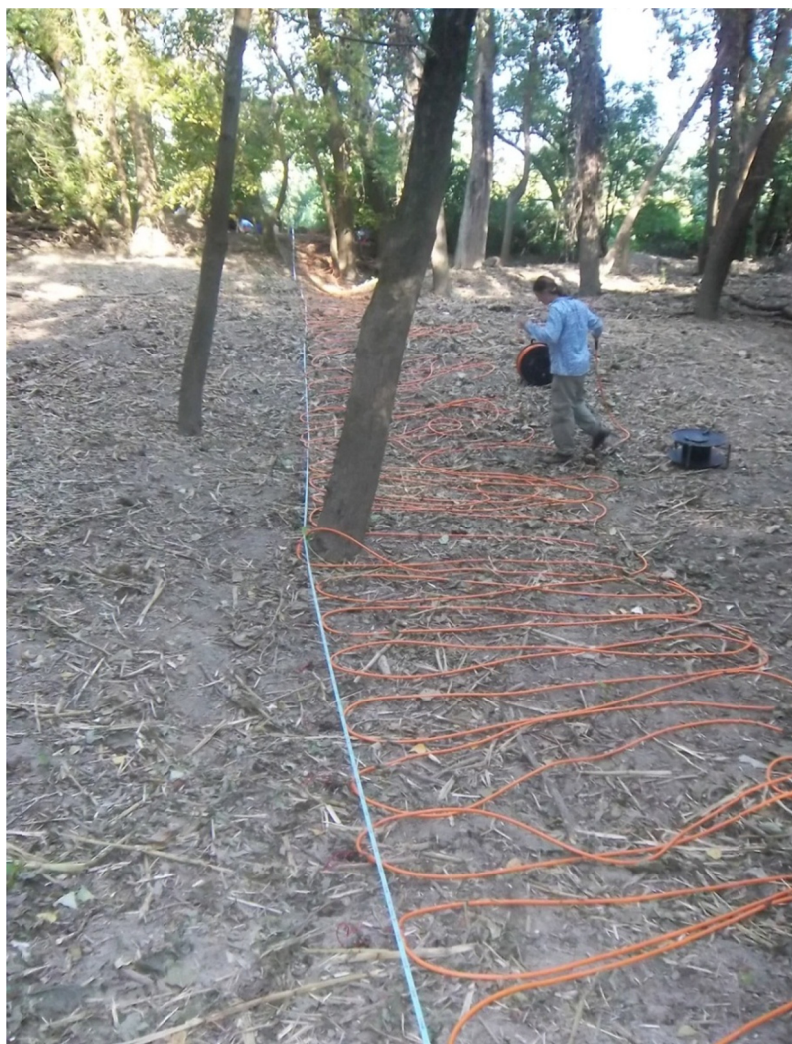
Illustration 14 : Photos illustrant l'installation du câble reliant les électrodes (espacées de 50 cm).
