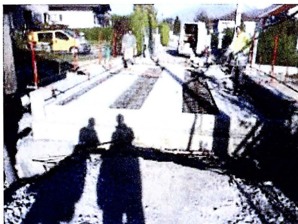
Figure 21 : Pose d'un tablier béton - Artefac (Frontenex, 2012)
