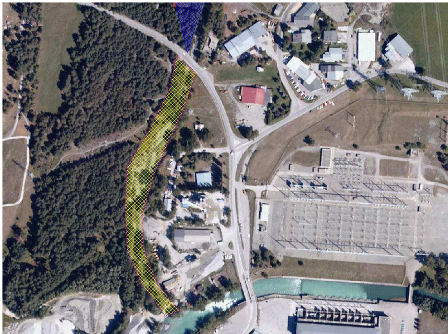
Figure 10 Le recalibrage du lit majeur à l'aval de la route départementale
