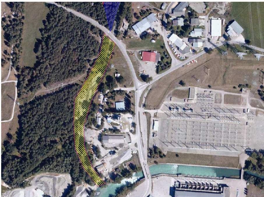
Photo 14 Le recalibrage du lit majeur à l'aval de la route départementale
