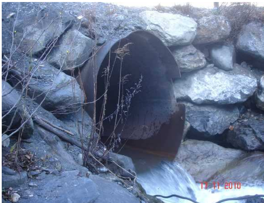
Photo 15 L'ouvrage avec sa buse
