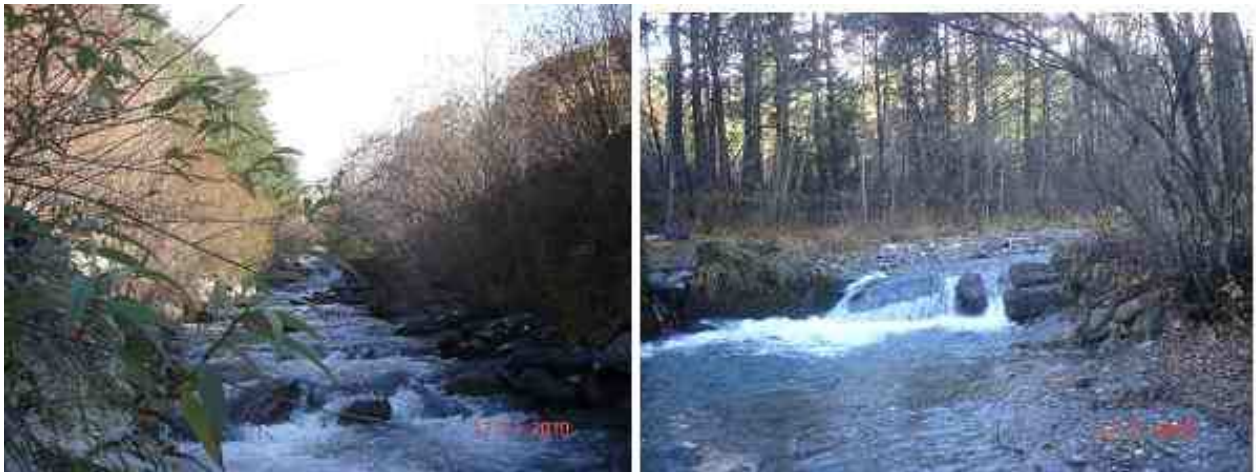
Photo 4 Photo 5 La partie basse du chenal en enrochements et le seuil à la cote 807
