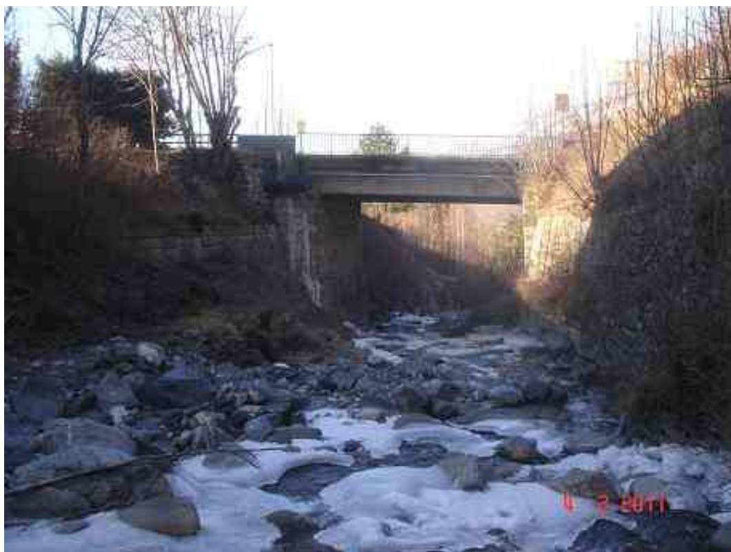
Photo 10 Le pont de la RD 1090
