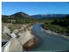
Barrage St-sauveur (aval)
