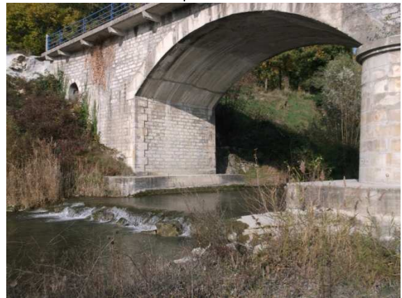
Prise d'eau (1) de la Filature de Pont de Barret
