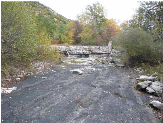
Prise d'eau (2) de la Filature de Pont de Barret
