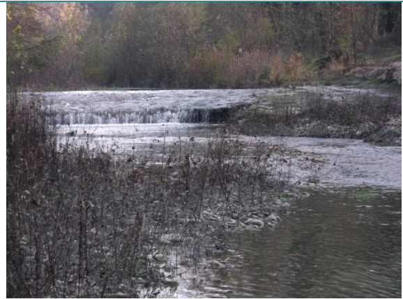
Seuil du pont de Manas
