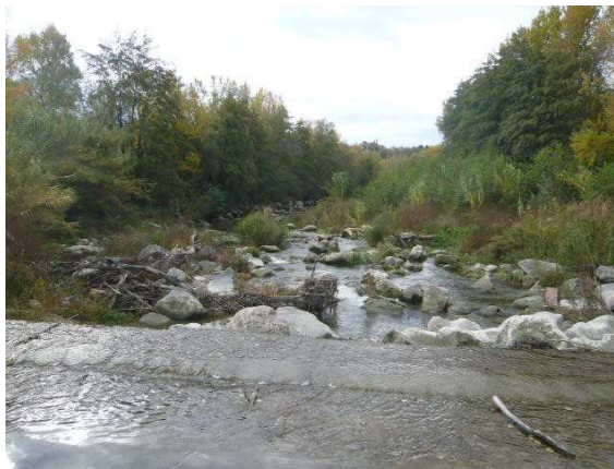
Contre seuil de Charols (protège une canalisation d'eau potable)
