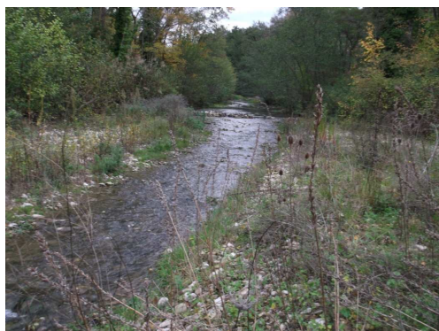
Photographie 24 Amont du pont de la ferme « Chardon » : des dépôts importants
