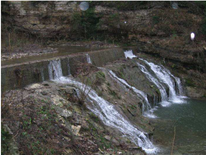
Seuil de la filature de Dieulefit. Obstacle infranchissable.
