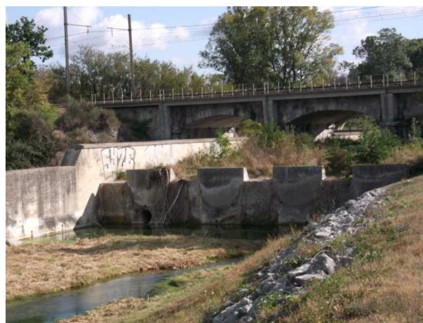
Photographie 29 Seuil de la voie ferrée.
