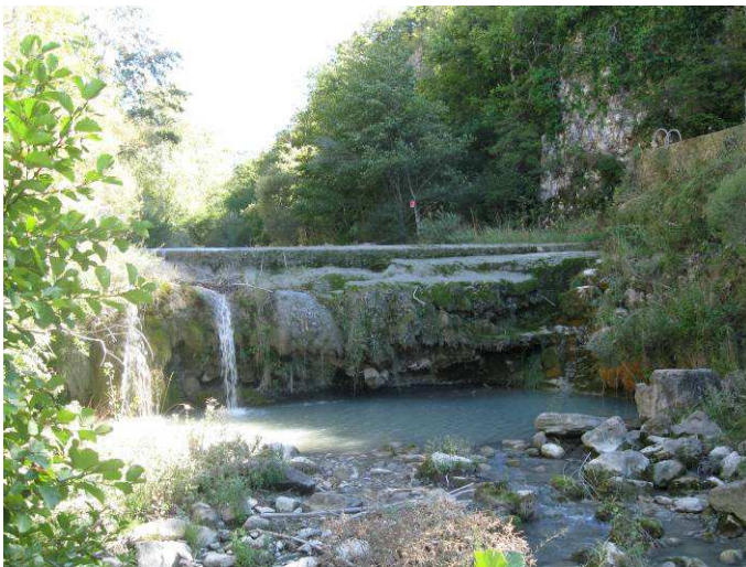
Le seuil de la fontaine de l'Étroit à l'amont de Crupies est infranchissable par les poissons à la remontée.
