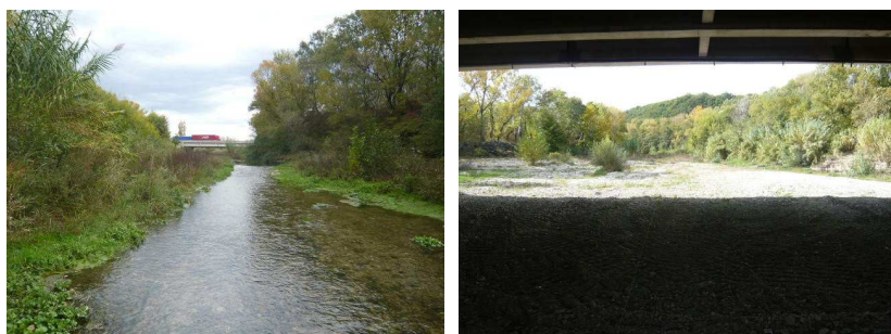
Photographie 7 Tracé rectiligne en aval du pont de l'A7 - Entretien au droit de l'ouvrage
