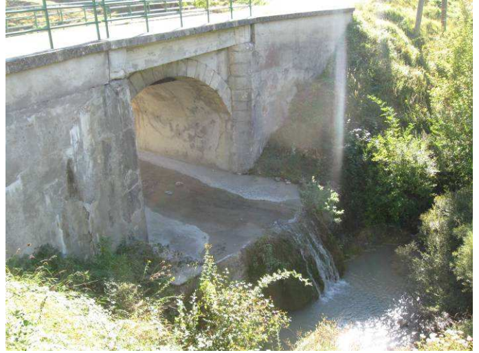
Seuil infranchissable sous le pont Rouge, à l'amont de Bouvières.
