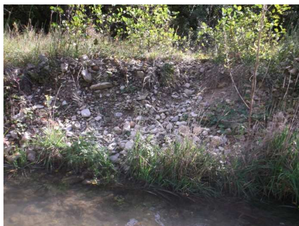
Photographie 20 Production de matériaux grossiers sur le tronçon 4.
