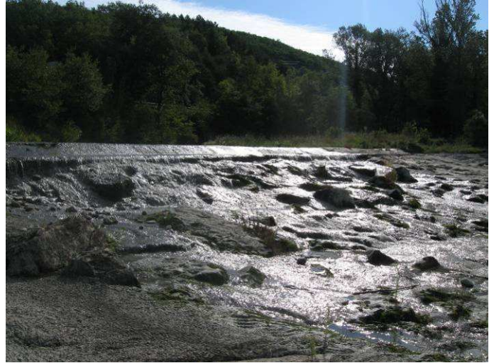
Seuil du moulin de Mornas, infranchissable à la remontée.
