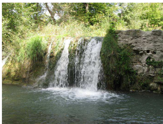
Seuil de prise d'eau à Gougne. Obstacle infranchissable
