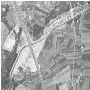
1968 – Construction du pont de l'A7 et recalibrage du Roubion
