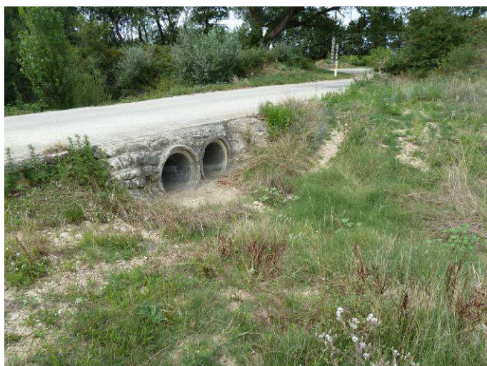
Ouvrage de franchissement à l'aval de Malataverne.
