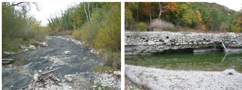
Photographie 3 Seuil de la prise d'eau des filatures de Manas et incision marquée en aval
