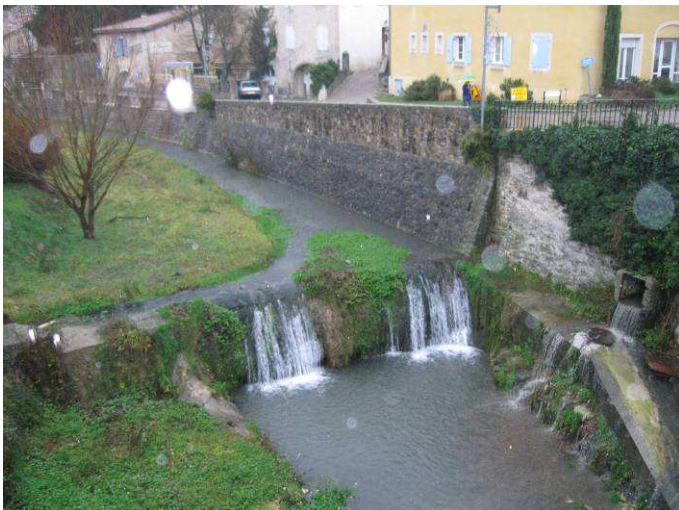
Seuil infranchissable dans Dieulefit.
