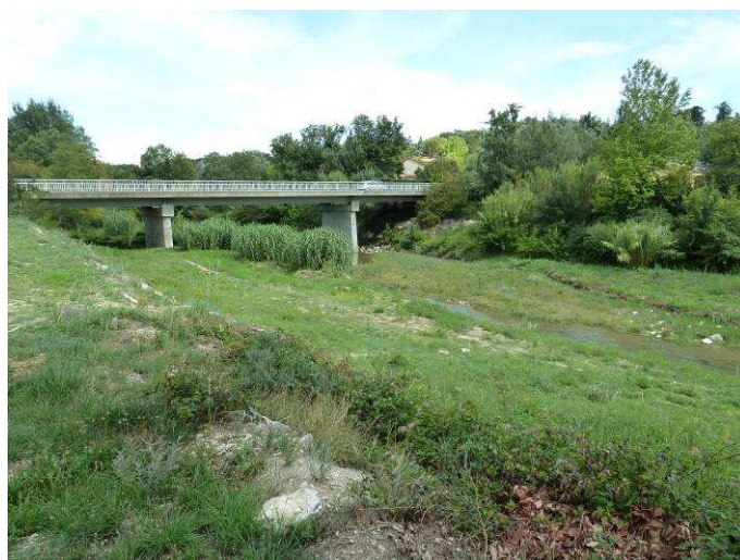
Le Roubion au niveau du pont de Bir Hakeim, à l'amont de l'agglomération de Montélimar. Le lit s'inscrit entre des berges aménagées. L'aspect du fond du lit devient progressivement plus naturel, signe d'une meilleure fonctionnalité.
