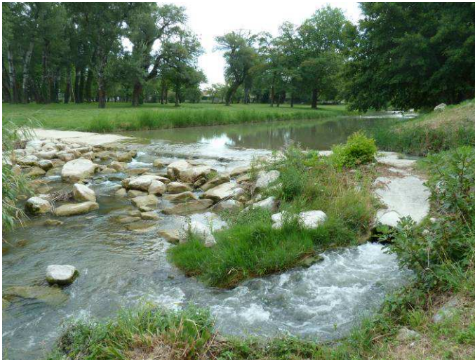
Le seuil à l'amont de la confluence avec le Roubion est partiellement franchissable.
