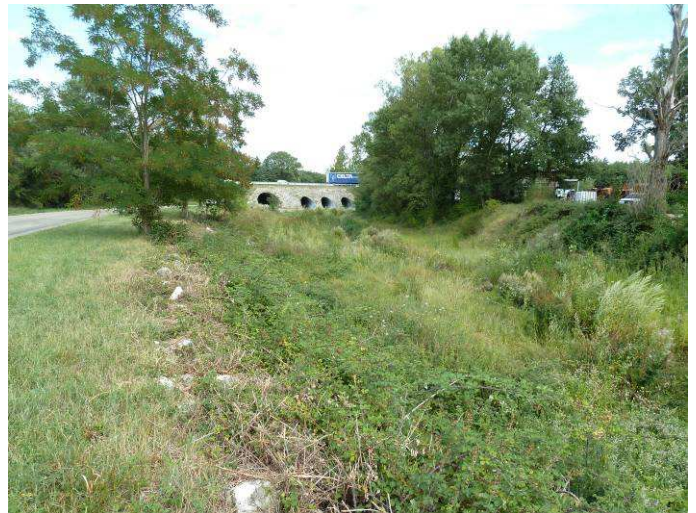
Le lit en aval du franchissement de l'A7. Écoulements résiduels serpentant dans les herbacées.
