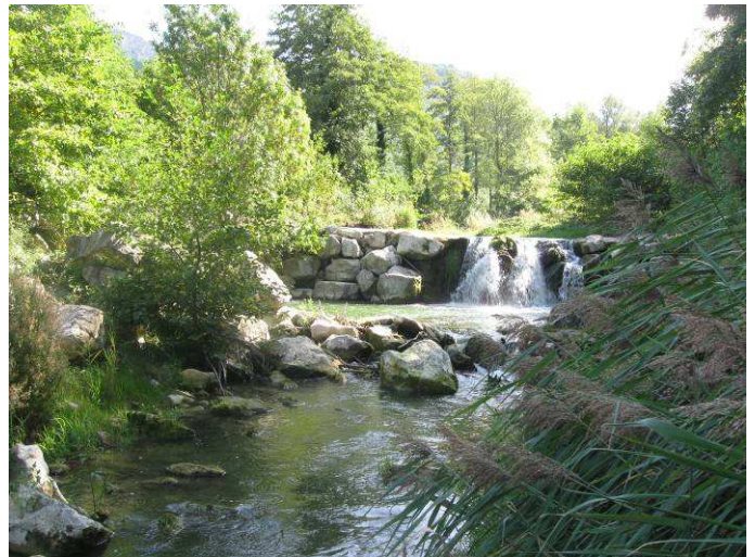
Seuil infranchissable au niveau de la pisciculture de la Bégude-de-Mazenc
