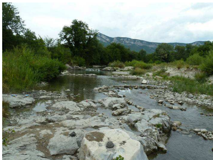
Seuil en travers du Roubion en aval de Saou (au fond). Ouvrage franchissable selon les conditions de débit.
