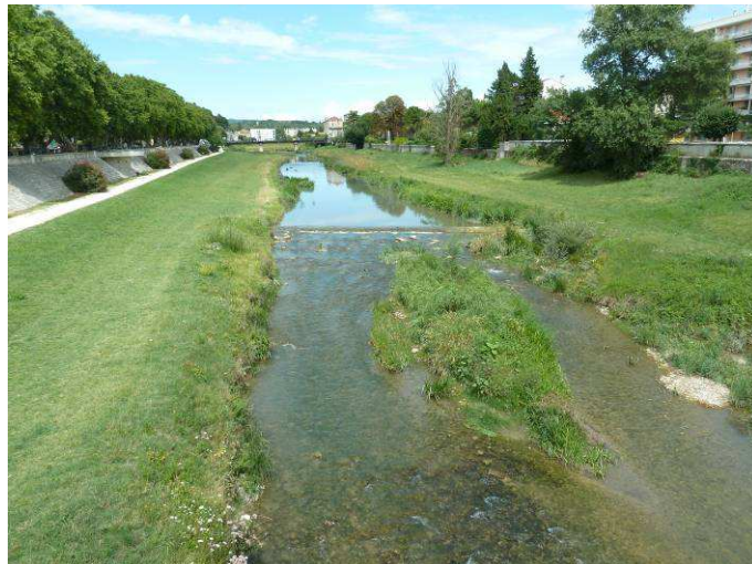
Seuil franchissable dans Montélimar. La fixation du lit par les aménagements paysagers limite l'hétérogénéité des faciès d'écoulement.
