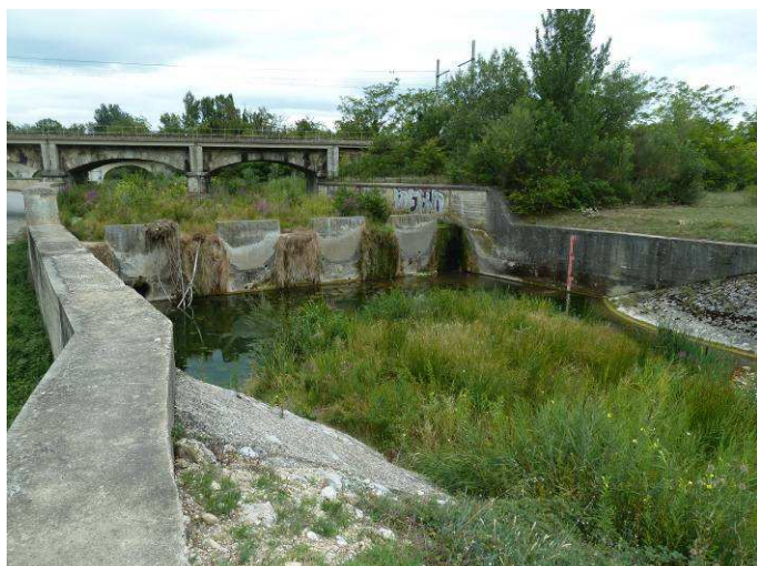
Seuil infranchissable en aval de la voie ferrée.
