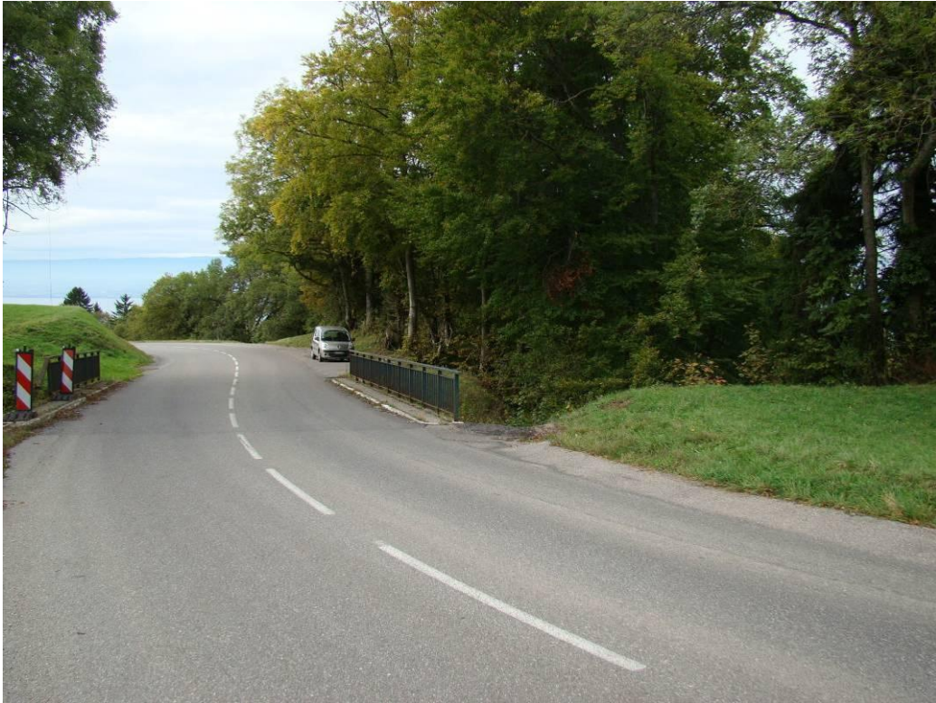
La situation d'une des voies de passage du corridor, le long de la ripisylve et juste après un virage serré, expose la faune et les automobilistes à un risque certain de collision. Photo : FRAPNA 74
