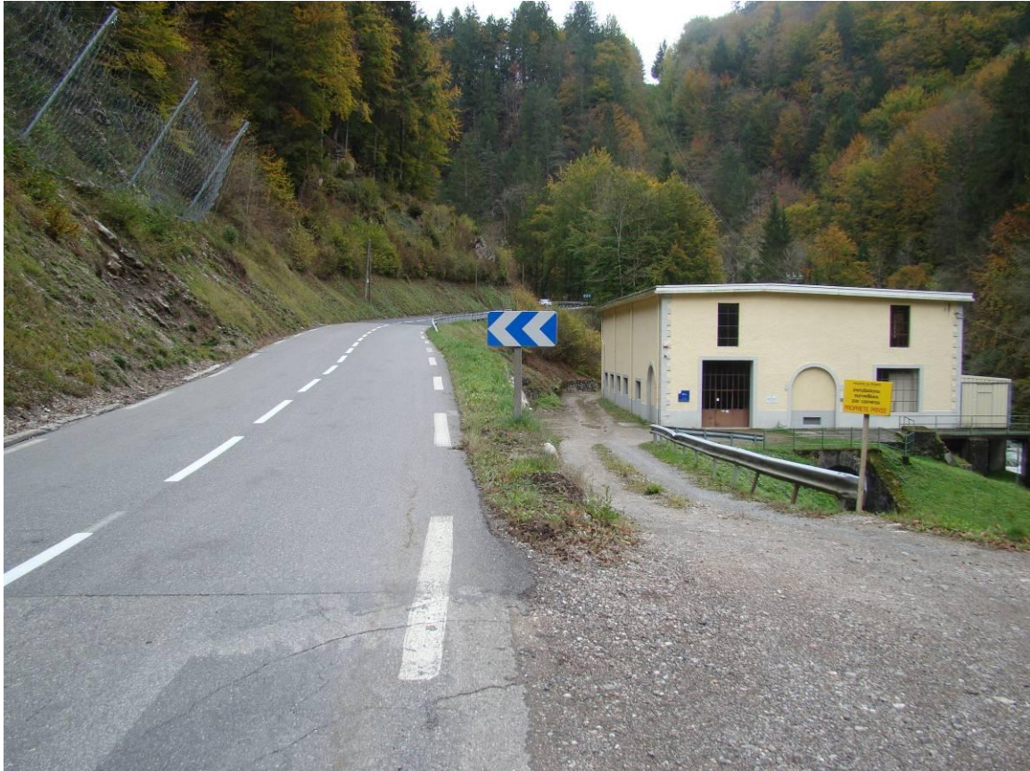
Les abords routiers, le tracé routier sinueux, la vitesse parfois excessive des automobilistes rendent la traversée difficile et dangereuse. Photo : FRAPNA 74
