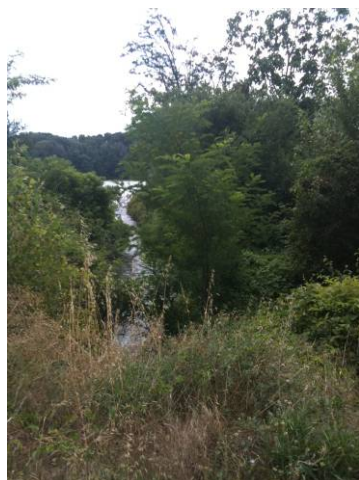
Sortie de la pompe vers le Vieux Rhône
