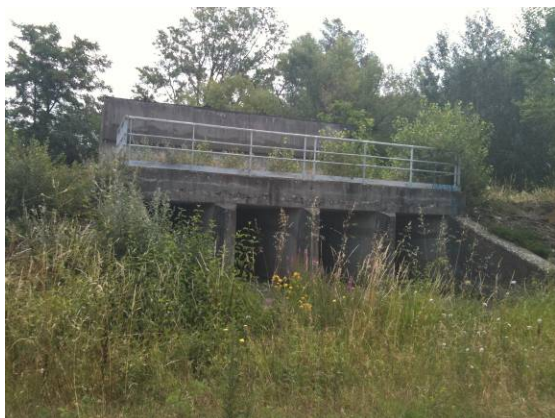
Porte d'écluse à doubler
