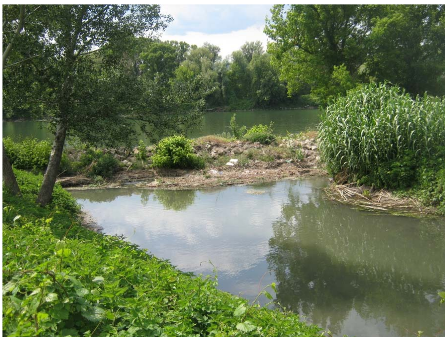
Figure 13: Ecoulements bloqués par la digue et accumulation de résidus au niveau de l'exutoire de la lône des Joncs (source : Egis)
