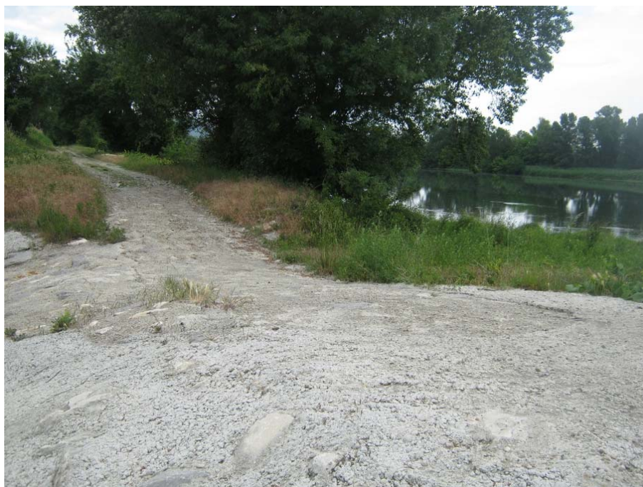
Figure 8: Abaissement de la digue pour faciliter le remplissage de la lône des Dames (source : Egis)
