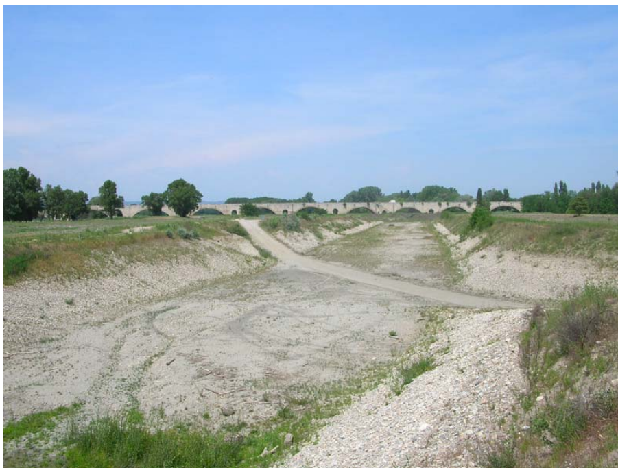
Figure 16: Vue vers l'amont depuis l'exutoire de la lône Projet (source : Egis)
