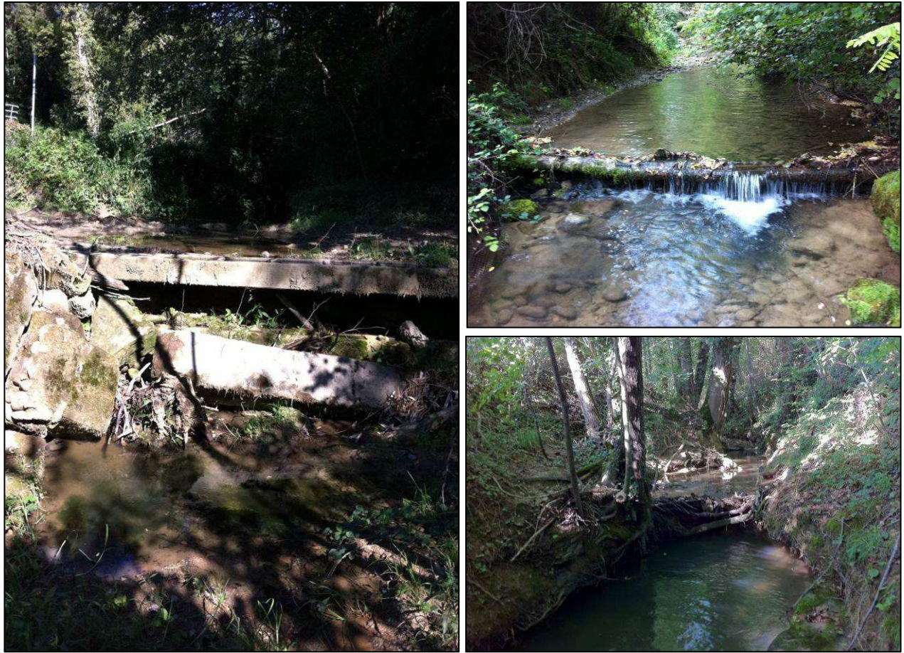
Fig.09 : Exemples de seuils présents sur la Joyeuse : seuil artificiel situé en amont du tronçon (image de gauche), seuil piscicole en rondins de bois de diversification des écoulements (image en haut à droite) et seuil naturel formé par le système racinaire des arbres situés en berge (image en bas à droite) - ( Source : GREN, Septembre 2011).
