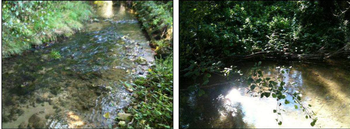
Fig.12 : Illustrations des types de protections de berges observées sur le tronçon considéré. Image de gauche, protection de berge artisanale (poteau béton présent en berge). Image de droite, fascine de saules permettant la stabilisation du pied de talus. ( Source : GREN, Septembre 2011).
