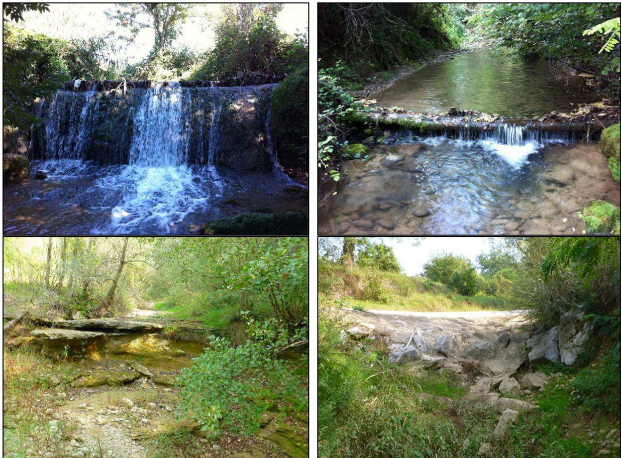
Fig.03 : Ouvrage transversal de type seuil représentant un point de blocage de la dynamique naturelle du cours d'eau (continuité sédimentaire et piscicole). ( Source : GREN, Juillet 2011).
