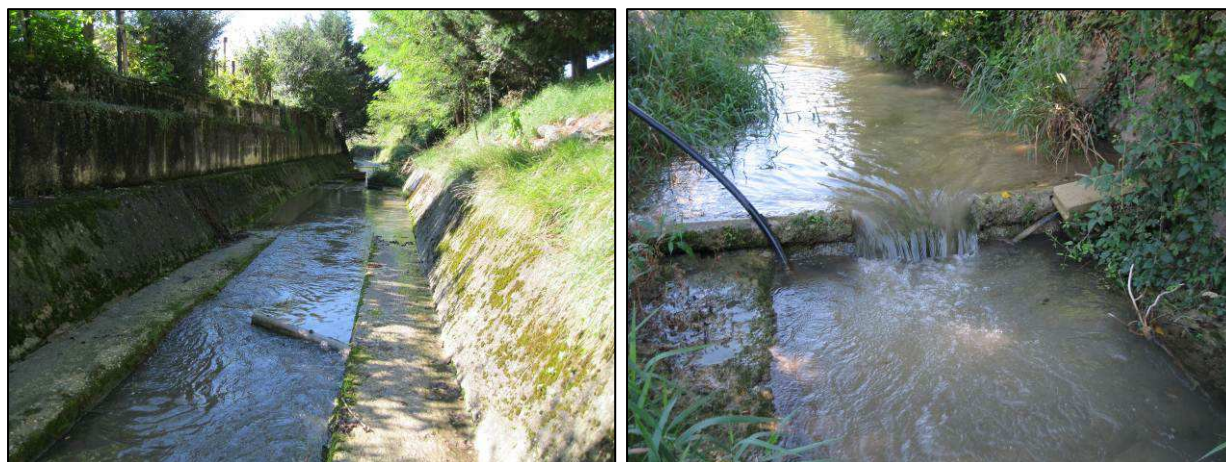
Fig.26 : Illustrations de la cunette béton et aménagements de diversification présents dans la traversée urbaine de Saint Paul les Romans. ( Source : GREN, Septembre 2011).
