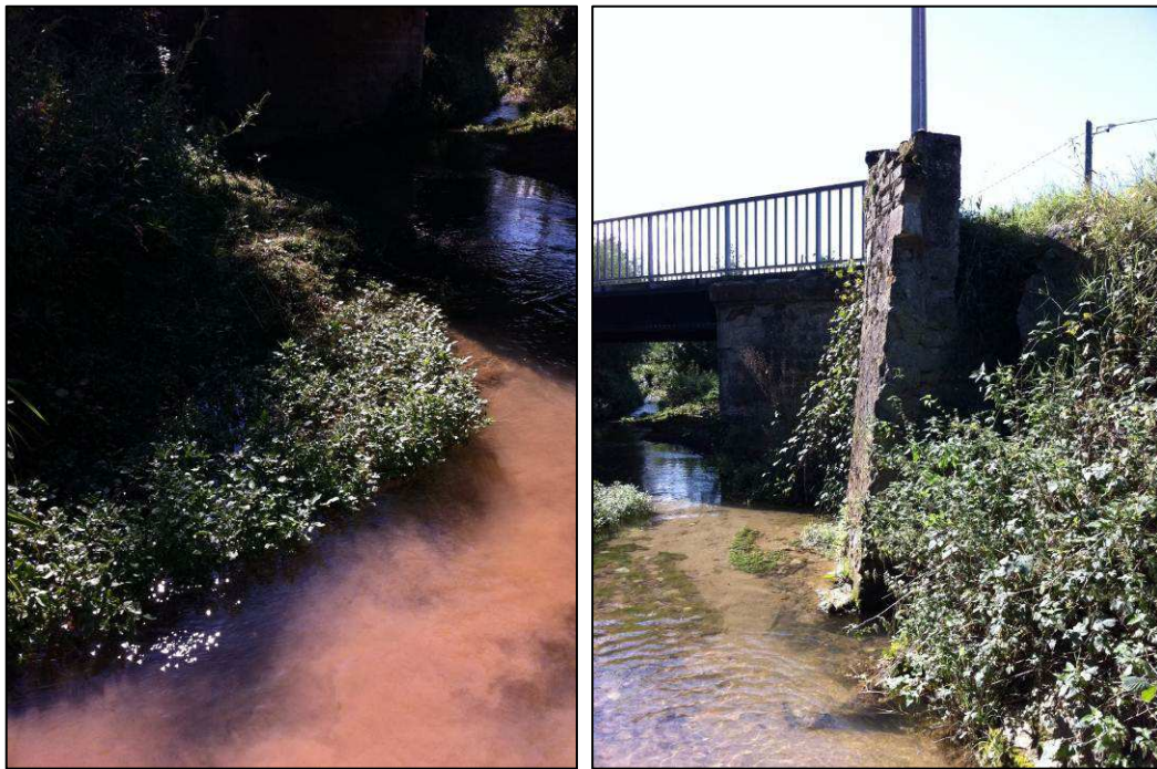
Fig.16 : Illustrations des phénomènes de colmatage des fonds observés lors des investigations de terrains. ( Source : GREN, Septembre 2011).
