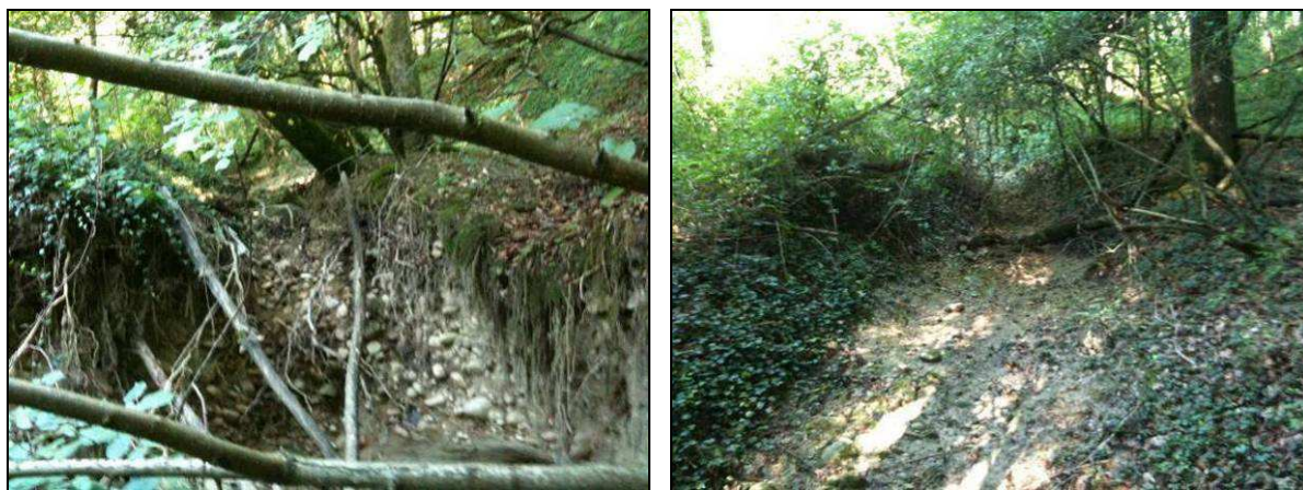
Fig.04 : Illustrations des phénomènes d'érosion observés sur le secteur amont de la Joyeuse lors des investigations de terrain. ( Source : GREN, Septembre 2011).
