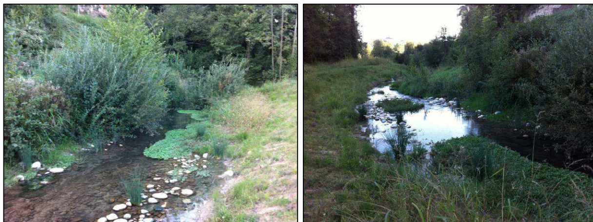
Fig.08 : Opération de restauration morpho-écologique menée sur le tronçon aval du secteur considéré. - ( Source : GREN, Septembre 2011).
