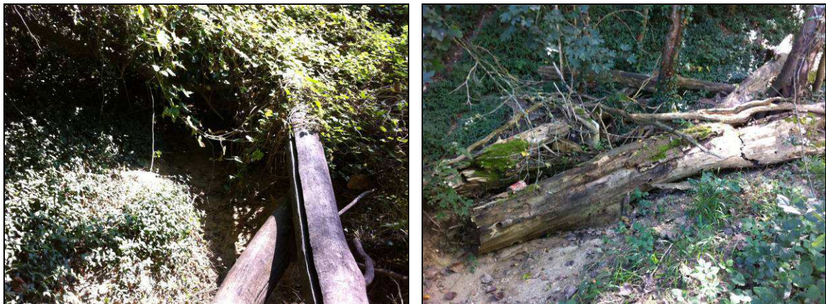
Fig.39 : Illustrations des embâcles mis en exergue lors des investigations de terrains. ( Source : GREN, Septembre 2011).
