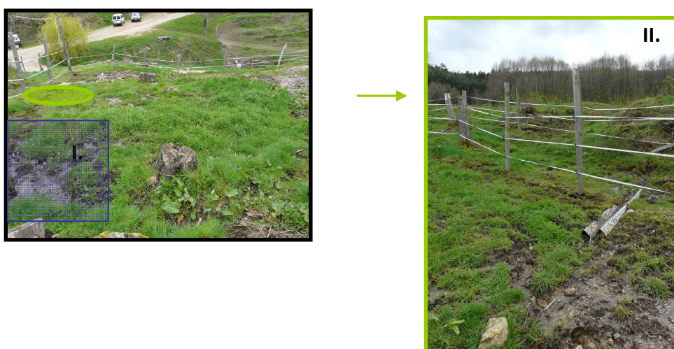
FIGURE 11 : Zone d'écoulement (I. Flaque d'eau temporaire, II. Conduite d'écoulement des eaux)
