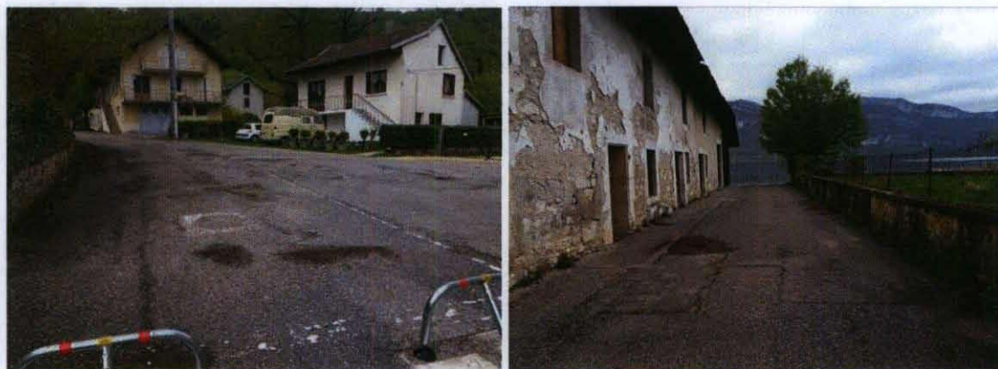
Figure 17 : accès par le chemin de la Chatière (Source : photos CIDEE)
