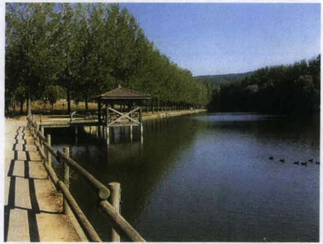
Berges rive droite artificialisée par un muret béton
