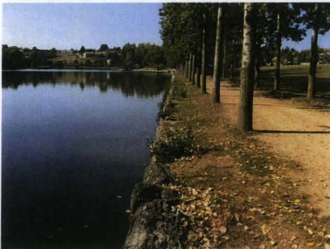
Berge rive droite (ouest) artificialisée par des enrochements et une allée de peupliers
