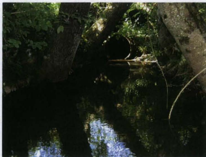
Buse (D=1m) sous la digue
