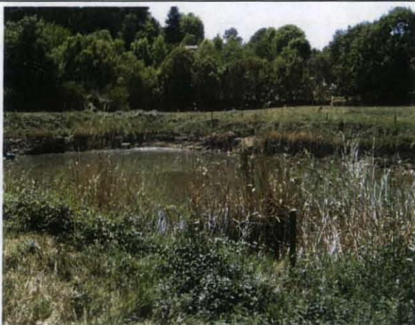
Trou agricole - vue depuis l'amont
