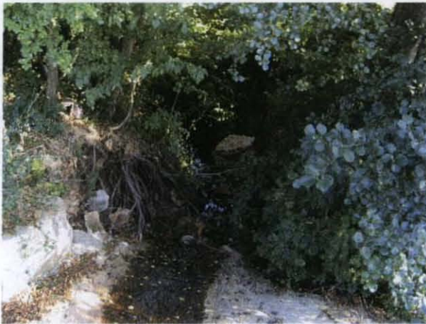
Sortie de l'ouvrage busé – début tronçon T0
