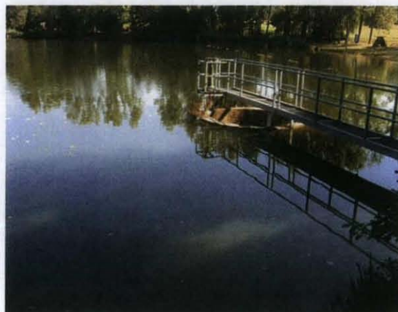
Ouvrage de trop-plein du lac
