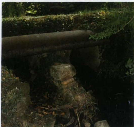
Ouvrage de franchissement en amont du lac
