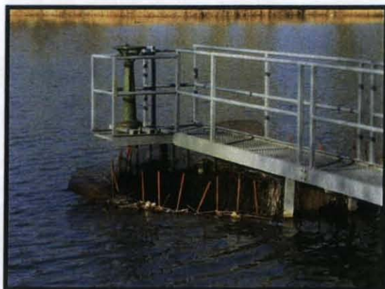
Photographies 5 : Buse déversoir, passerelle, volant à crémaillère et dégrilleur
