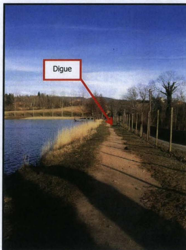
Photographie 3 : digue du plan d'eau
