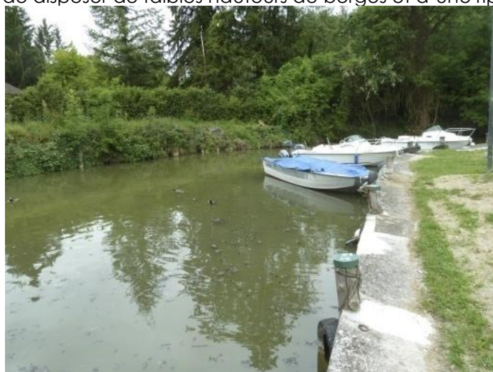
Photo 8: Vion sur le tronçon n°12 (TEREO)
