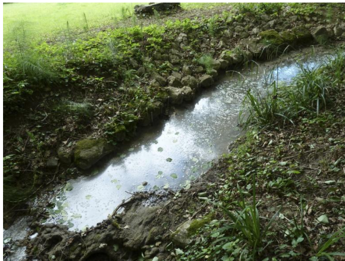
Photo 12: Le Mercube sur le tronçon n°115 (TEREO)
