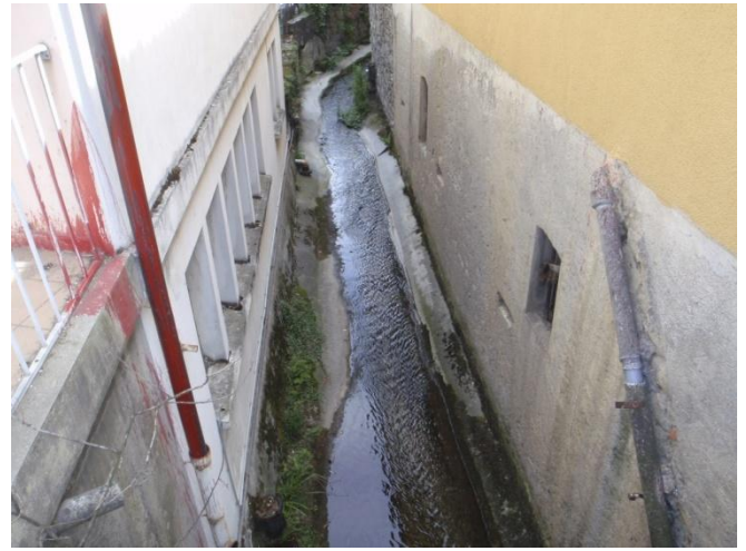
Photo 7: Passage du ruisseau de la Folle dans le centre ville de Bons en Chablais (TEREO)
