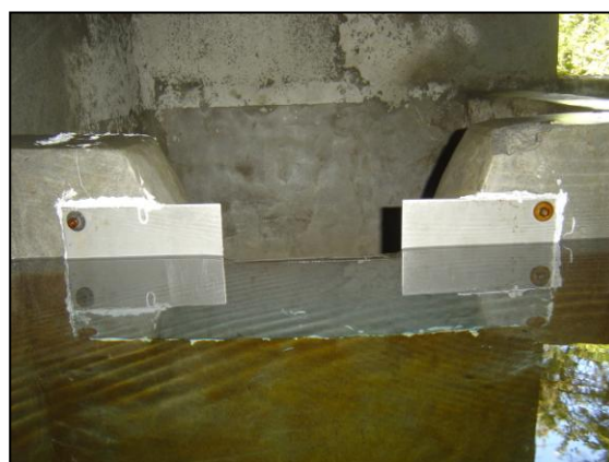
Photo 8 : Déversoir rectangulaire au captage de l'Épinguy
