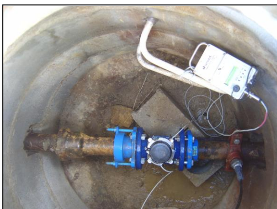
Photo 6 : Le système de comptage du débit au captage des Granges Mamet
