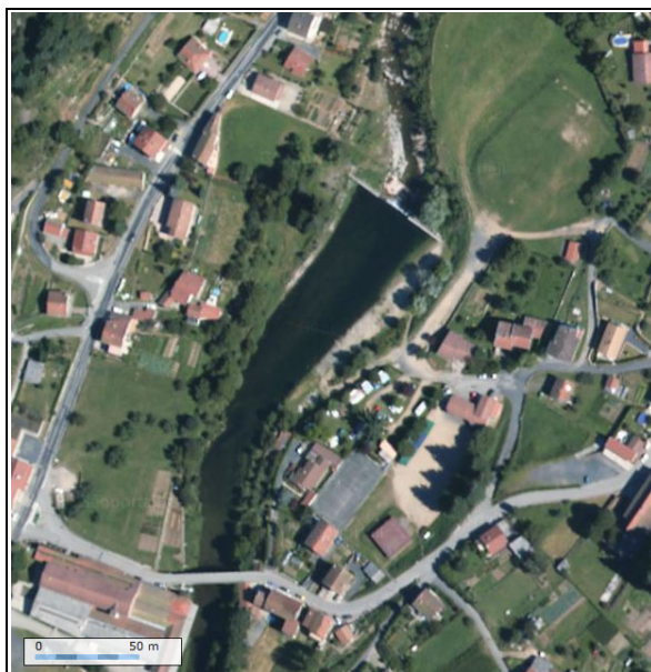
avec mise en eau (2,5 mots/12)
