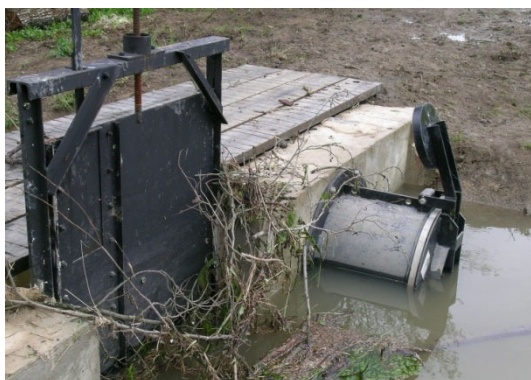
Figure n°II.12. Système de contrepoids pour remplissage automatique de la frayère de Polliat.
