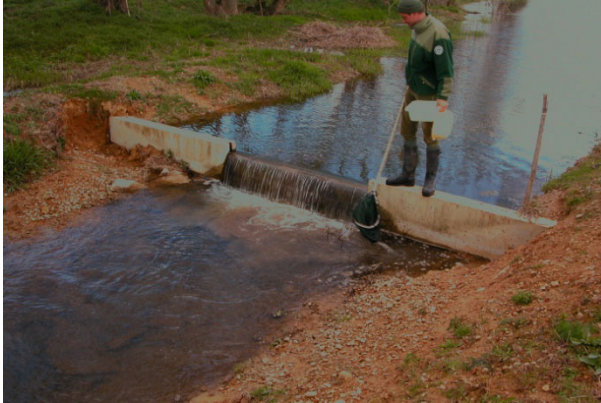
Figure n°II.8. Erosion autour du mur de l'ouvrage de la frayère de St Jean les Planches (21/07/2007).
