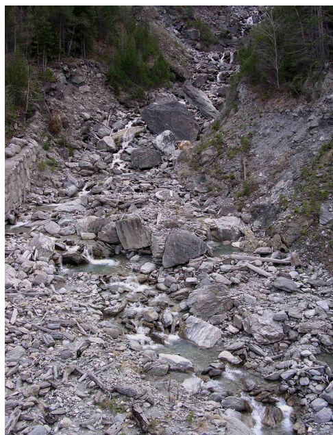
Figure 15 : amont du pont du Nant
