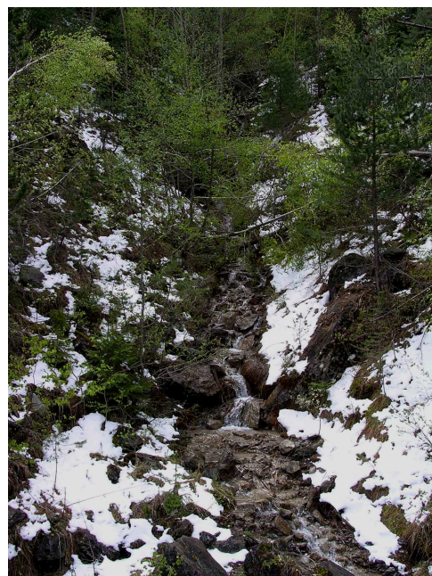
Figure 3 : ruisseau de Croix Rousse en amont de la RN6
