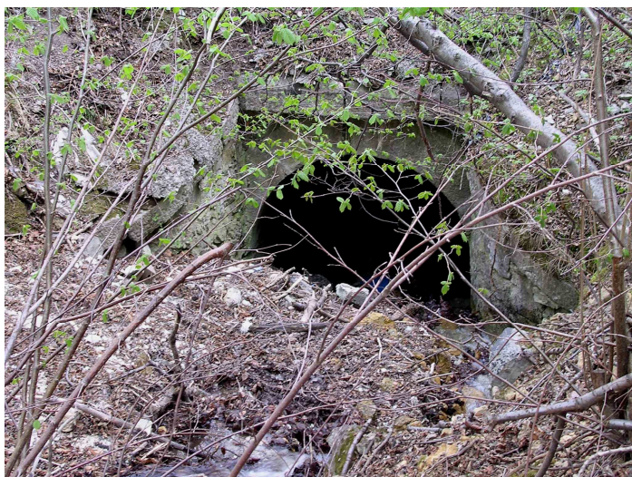
Figure 18 : ouvrage de franchissement de la RD215
