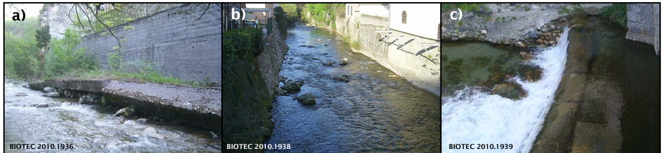
Figure 6. Différentes vues du tronçon T2, avec :
