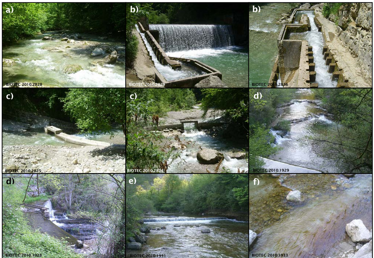
Figure 5. Différentes vues du tronçon T1, avec :
