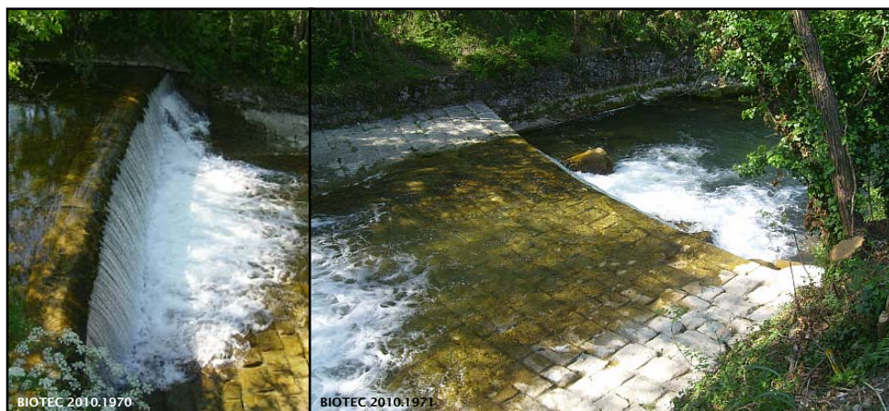
Figure 3. Illustrations du type de seuil caractéristique de ce tronçon de la Leyse avec des moellons parfaitement appareillés (photos Biotec, 29.04.2010).
