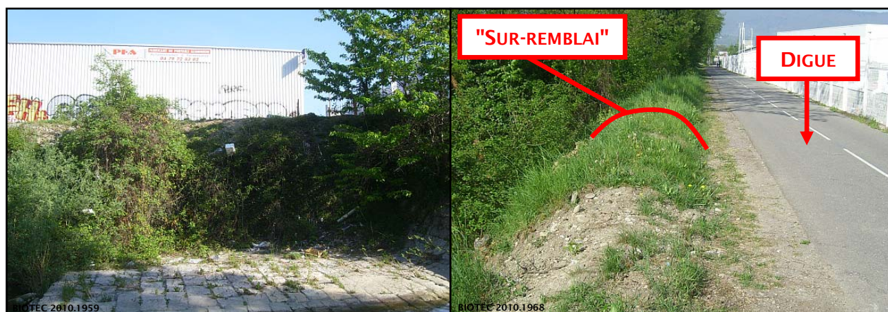
Figure 4. A gauche, berge raide en remblai. A droite, piste cyclable sur digue séparée de la Leyse par un merlon en "sur-remblai" sur berge (photos Biotec, 29.04.2010).
