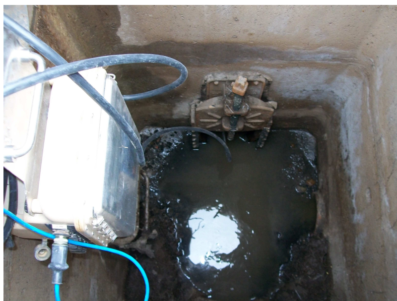
Point n°7 en amont du pompage de la Tuilerie
