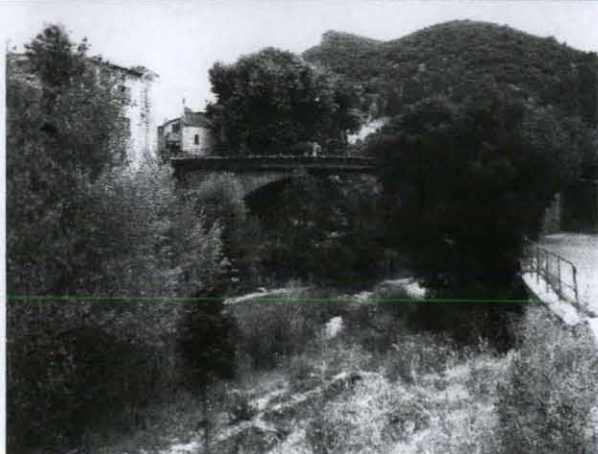
Canal empierré de la Serre au premier plan vu en aval du pont de Mollans/Ouvèze
