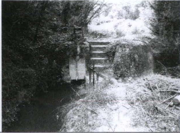
Vanne de prise du canal des Iscles du Vif en rive gauche de l'Ouvèze
