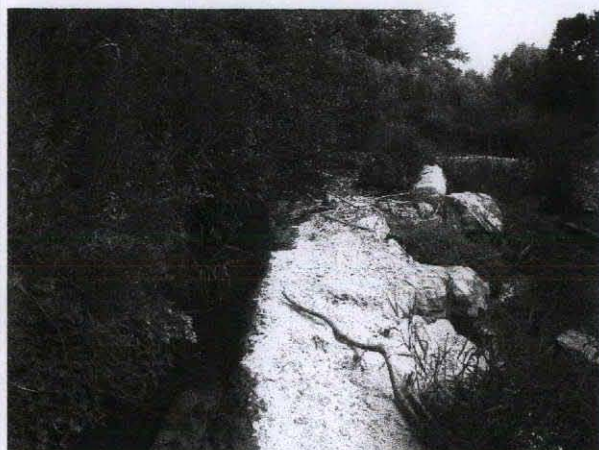
Vue vers l'amont de la prise en béton du canal des Gravennes (dimension 30x30cm environ)
