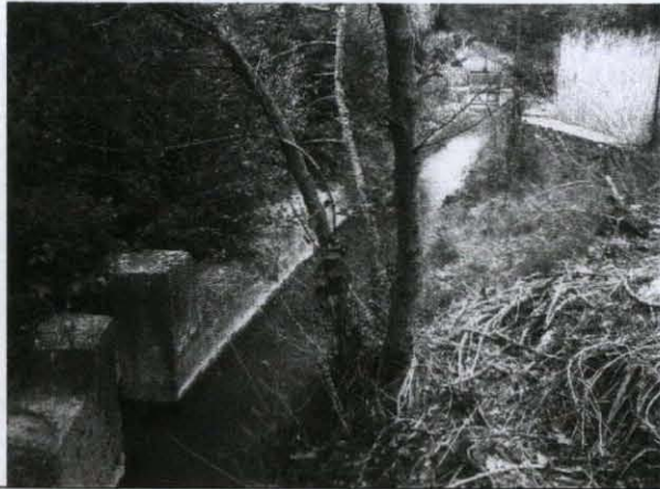
Vue de la vanne de prise du canal de Bluye sur la commune de Pierrelongue en rive gauche de l'Ouvèze
