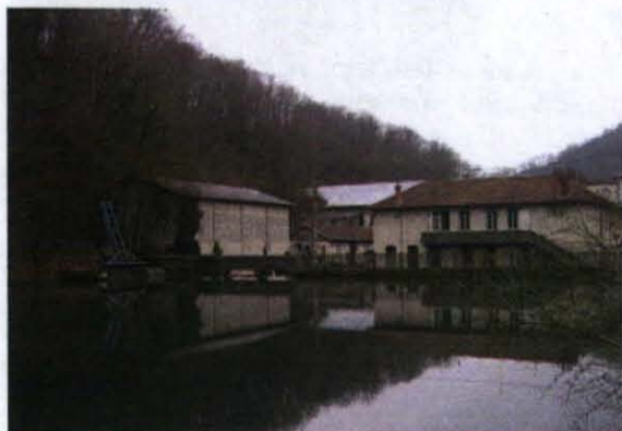
Barrage des Papeteries de Renage vue de l'amont
