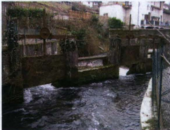
Vannes vues depuis l'amont
