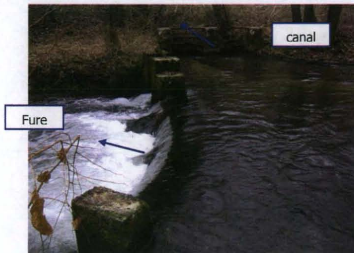
Prise d'eau à l'amont du secteur de PASTIÈRES
