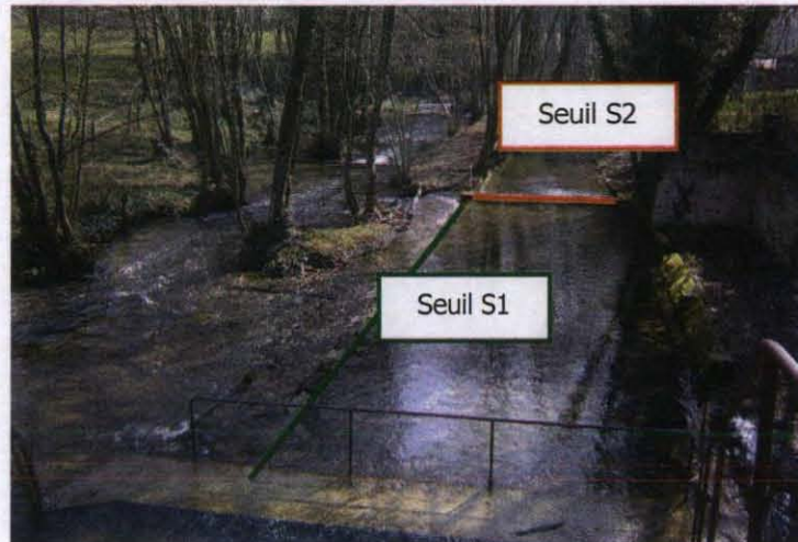
Prise d'eau du lavoir de Charavines (Fp4)
