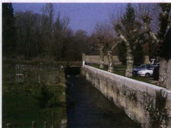
Vue de Fb1 depuis l'aval
