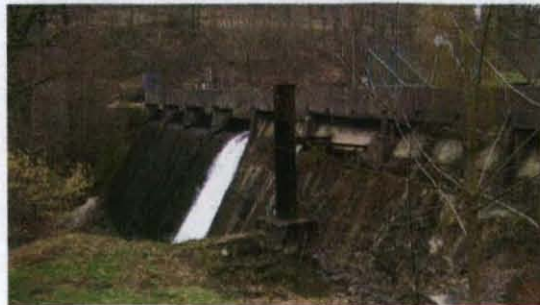
Barrage d'Hurtières vue de l'aval
