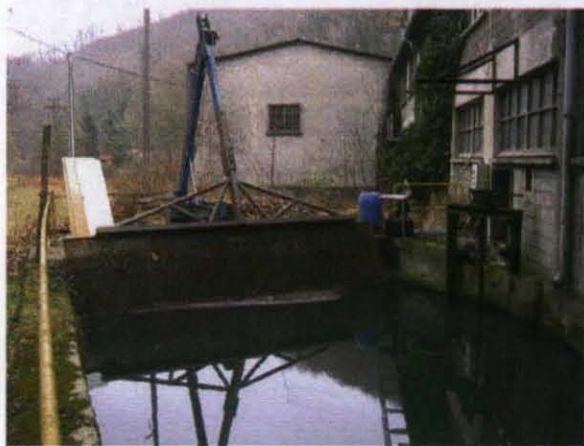
Départ conduite forcée à l'aval de la prise d'eau de Petite Hurtières
