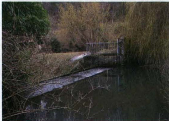
Seuil de la Poype vue de l'amont
