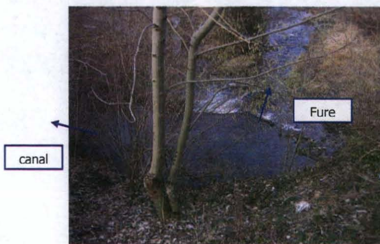
Prise d'eau secteur Ravignhouse vue de dessus
