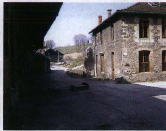
Vue de Fb2 depuis l'aval
