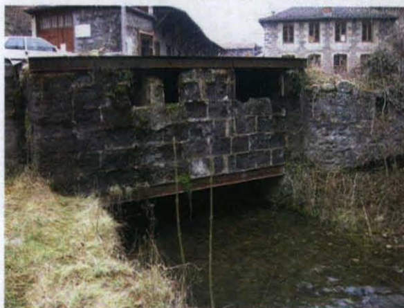
Sortie du canal de dérivation sous le site du Guillermet
