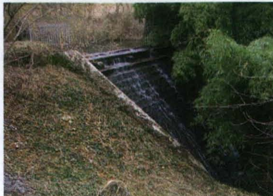
Seuil de la Poype vue de l'aval
