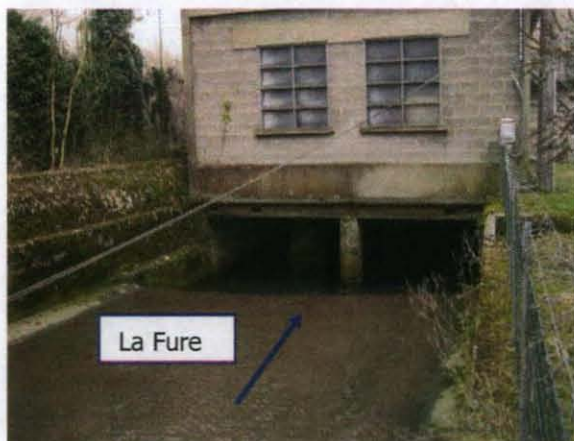
Entrée du passage couvert
