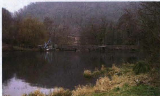
Barrage d'Hurtières vue de l'amont
