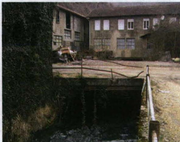
Vue de Fb14 depuis l'aval
