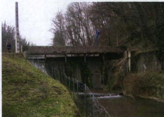
Barrage des Papeteries de Renage vue de l'aval
