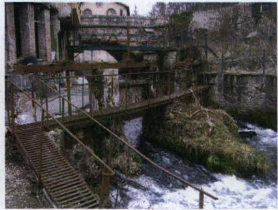
Vannes vues depuis l'aval
