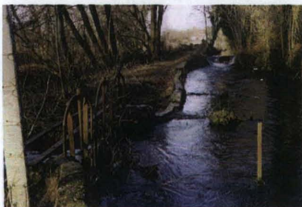
Vue amont depuis les vannes de la prise d'eau Fp2 (CSP, 1999)
