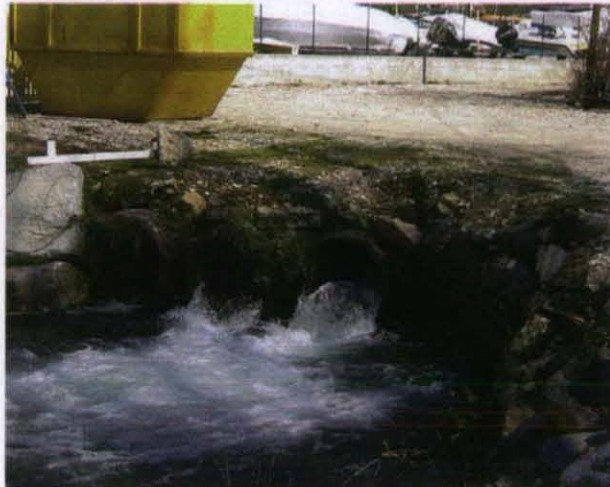
Vue aval des buses de l'ouvrage Ff15 (CSP, 1999)
