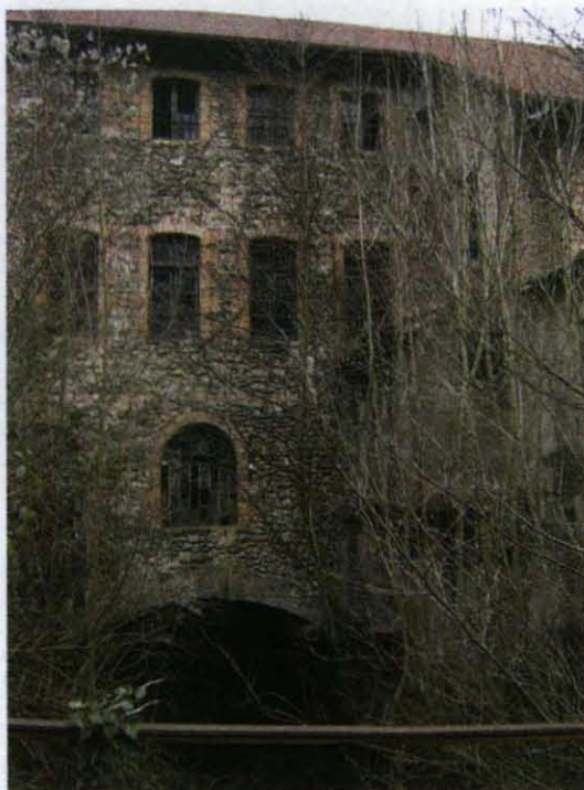
Vue de Fb6 depuis l'aval
