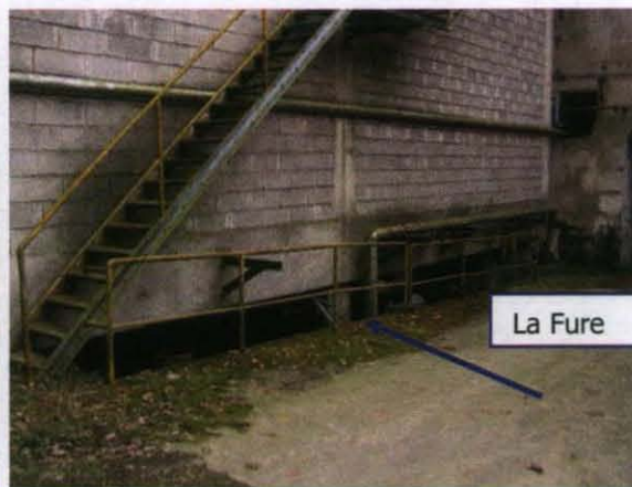
Passage sous une passerelle entre 2 bâtiments
