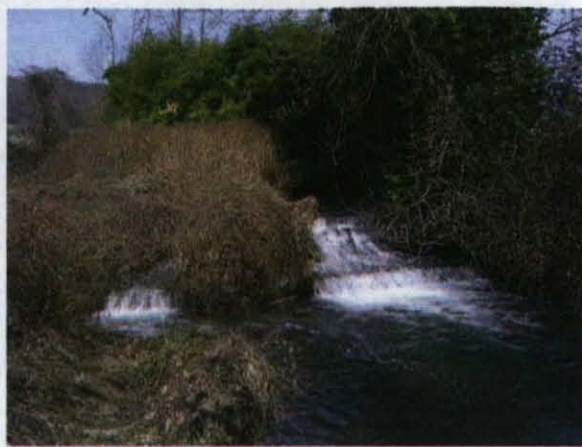
Seuils en travers du lit de la Fure
