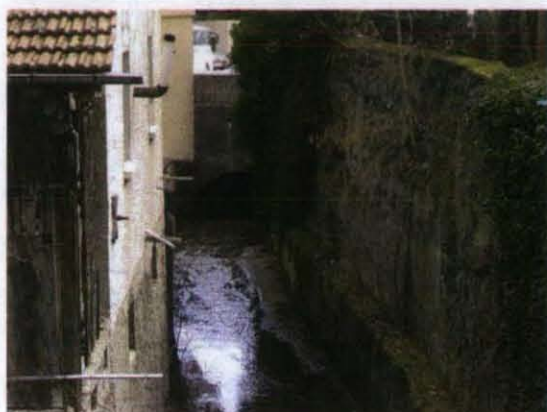
Entrée du passage couvert
