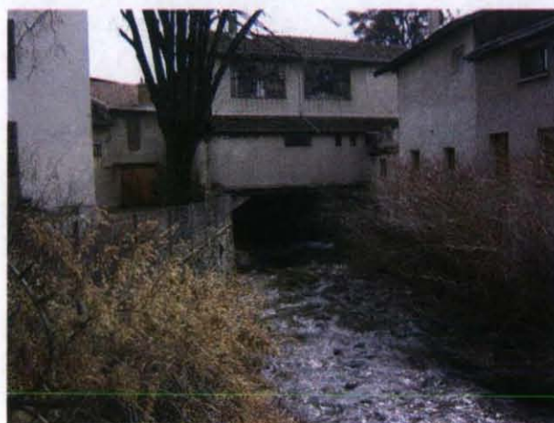
Entrée du passage couvert
