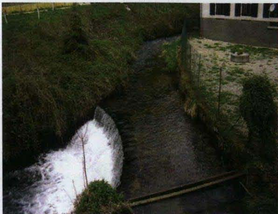
Ouvrage infranchissable sur le tronçon T32
