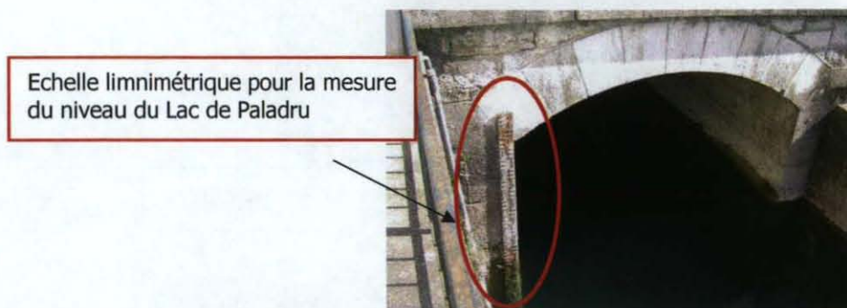
Photo 3 : Echelle limnimétrique pour la mesure du niveau du lac
