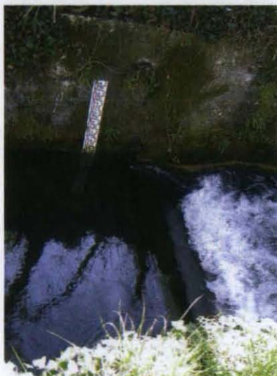
Photo 2 : Seuil jaugeur du canal de la Fure
