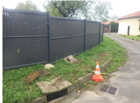
Boîte de branchement EP (à gauche) raccordée à une boîte de branchement EU (à droite)
