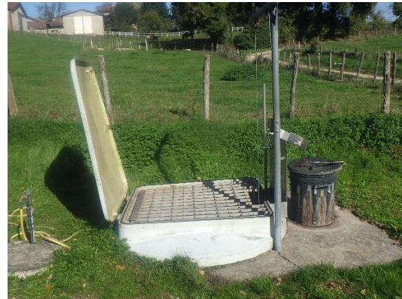
Vue extérieure PR entrée STEU Chef-lieu
