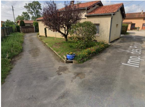
Avaloir raccordée à la boîte de branchement EU
