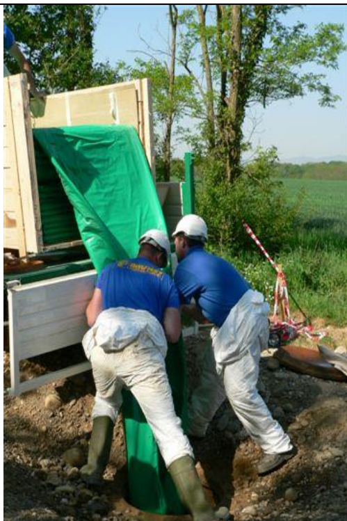
Pose de la gaine
