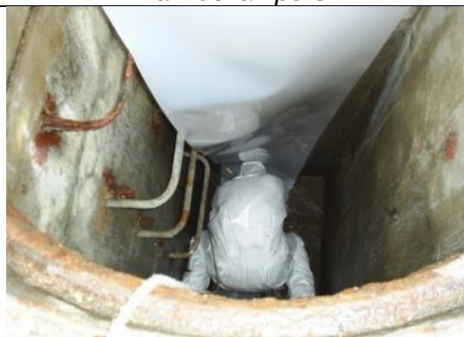
Mise en place du liner
