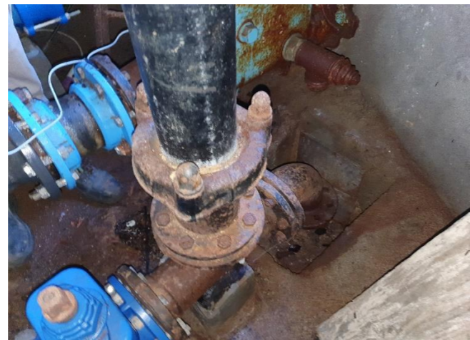
Vanne de vidange et sortie du trop-plein
