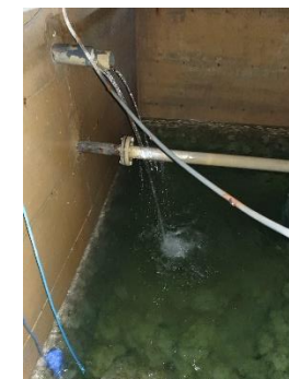
Arrivée des sources d'Abbenans dans la bache de reprise
