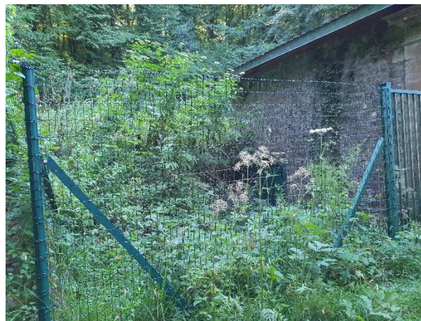
Clôture de la protection immédiate
