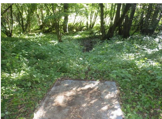
Vue d'ensemble et du Trop-plein
