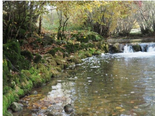
Figure 7. Enrochements présents en rive droite de la Valouse
