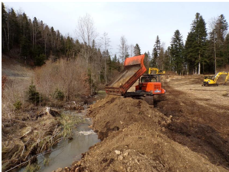
Figure 12 : Comblement de l'ancien lit
