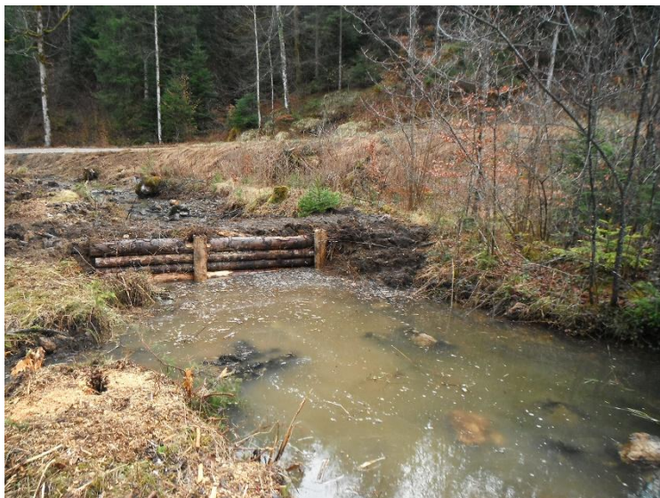
Figure 10 : Fascine et bouchon
