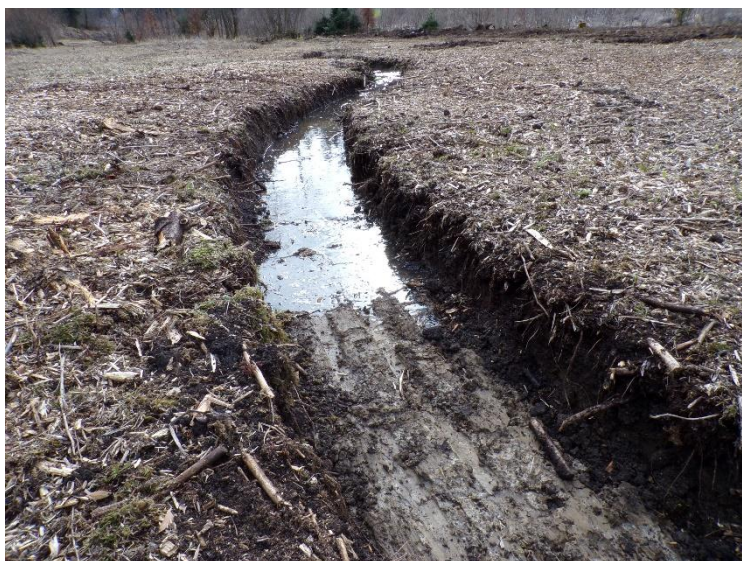
Figure 11 : Mise en eau du nouveau lit
