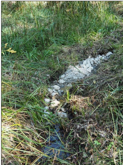
Figure 13 : Recharge en granulats du nouveau lit
