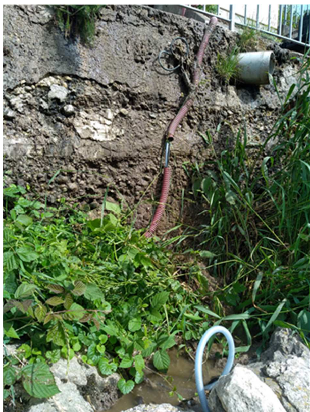
Photographie 5 : Rejet via le trop plein du poste de relevage du système d'assainissement d'Arçon (écoulements sur la dalle et le mur). Crédit photo J. Nicolet (EPAGE HD/HL)
