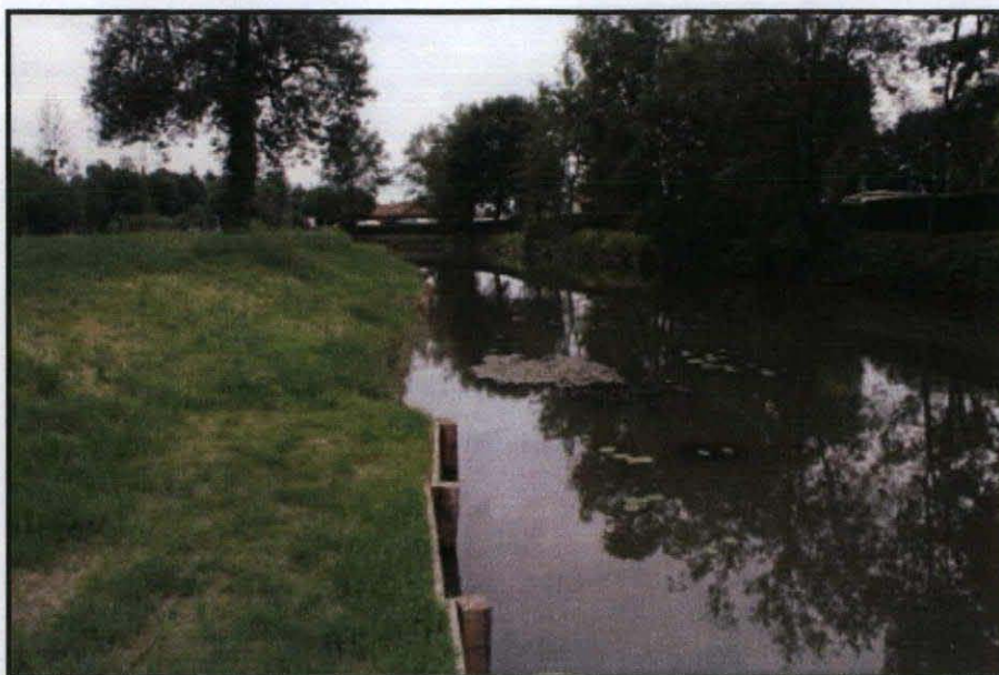
Figure 20 : Aménagement de berges à Vonnas
