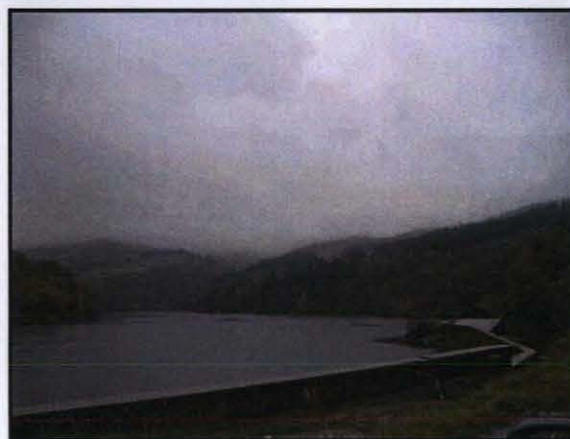
Barrage du Couzon
