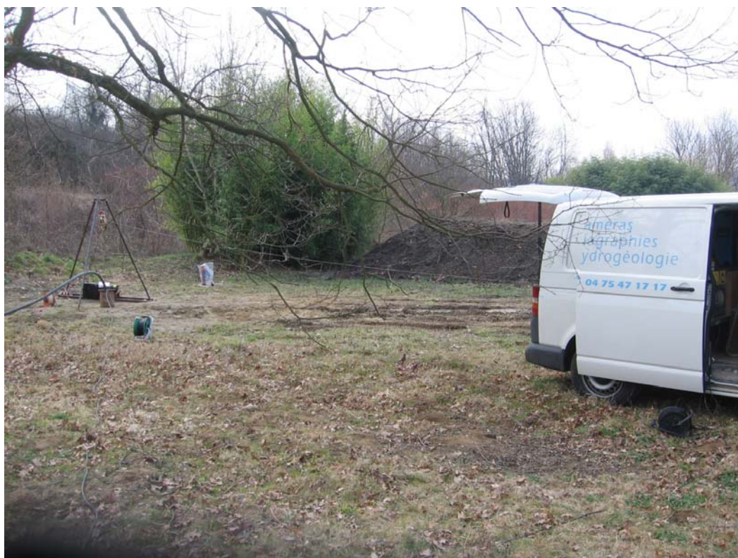
dispositif mis en place sur le piézomètre N°6
