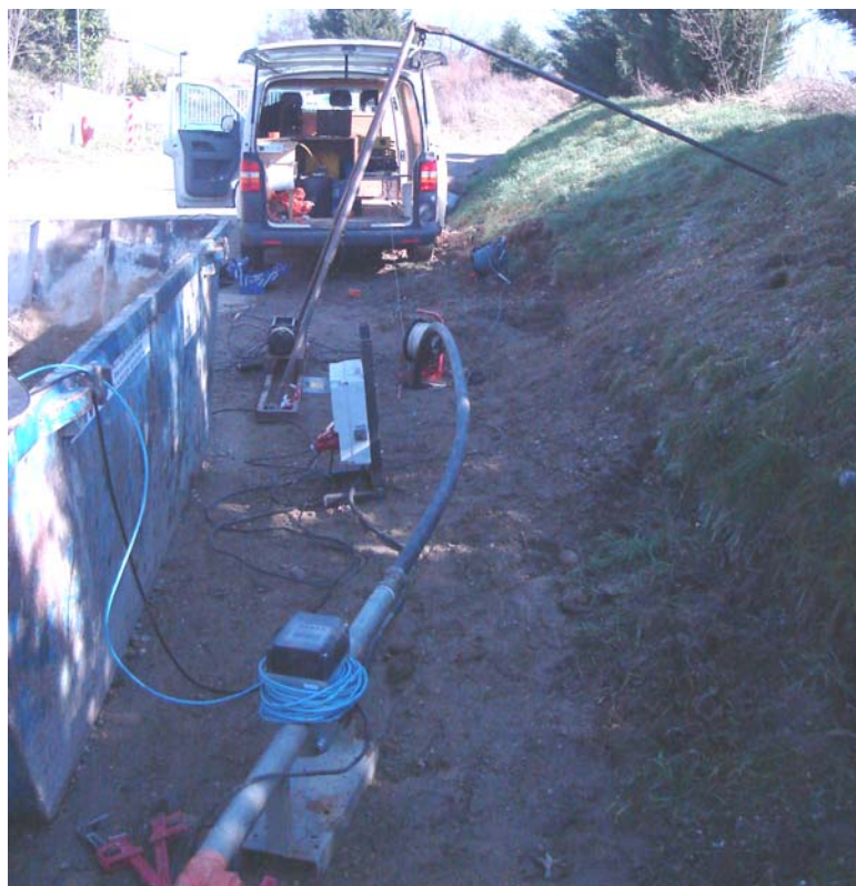
dispositif mis en place sur le piézomètre N°3
