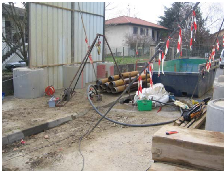
Dispositif mis en place sur le piézomètre N°1
