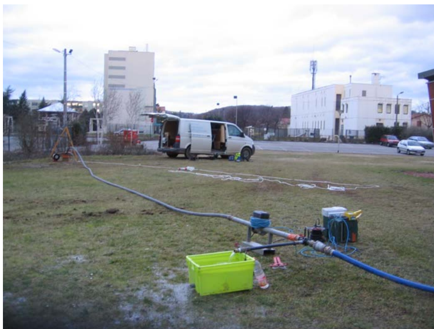
dispositif mis en place sur le piézomètre N°4
