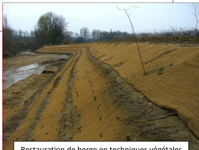
Restauration de berge en techniques végétales
